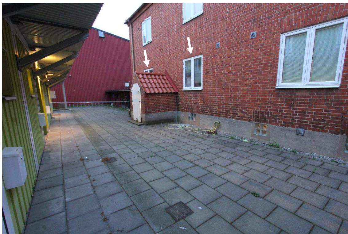
Figur 4. Baksidan av Hagstorgsgatan 4D. Fönster till rummen i den undersökta lägenheten markeras med pilar i bilden. Plåtdörren som syns i utbyggnaden mellan lägenhetens fönster har inte förbindelse med den undersökta lägenheten.
