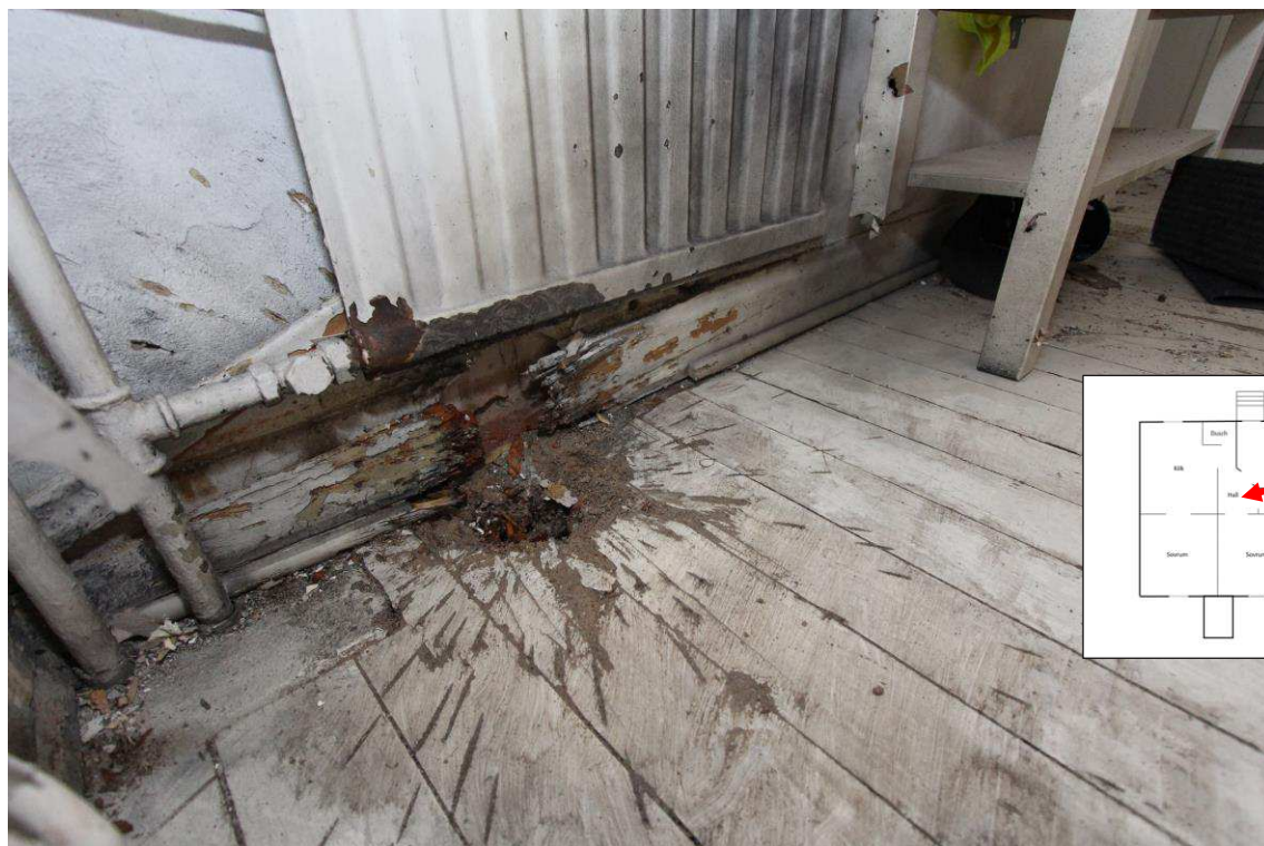
Figur 13. Krevadgropen i hallgolvet när golvet sopats rent. Splitterskadorna hade en radiell utbredning.
