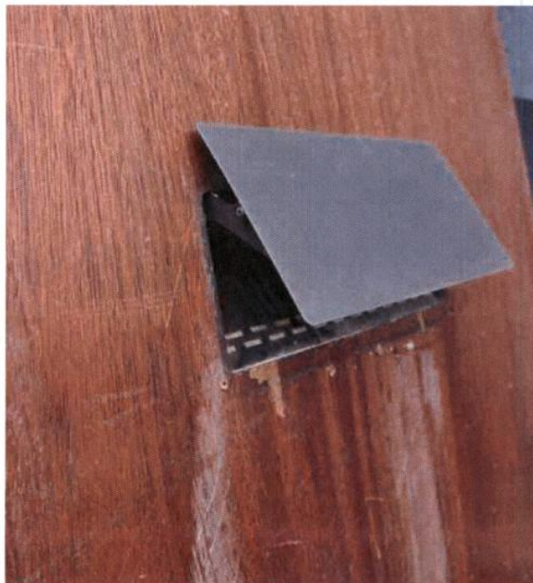
Bild 8 Sotskador på insidan av dörrbladet.
