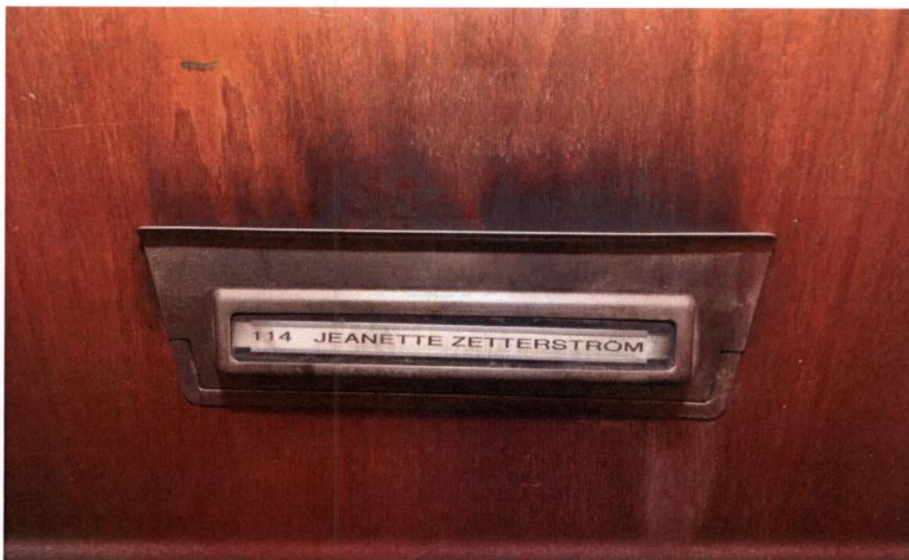
Bild 4 Närbild på brevlådeinkast med sotning på dörrbladet ovanför.
