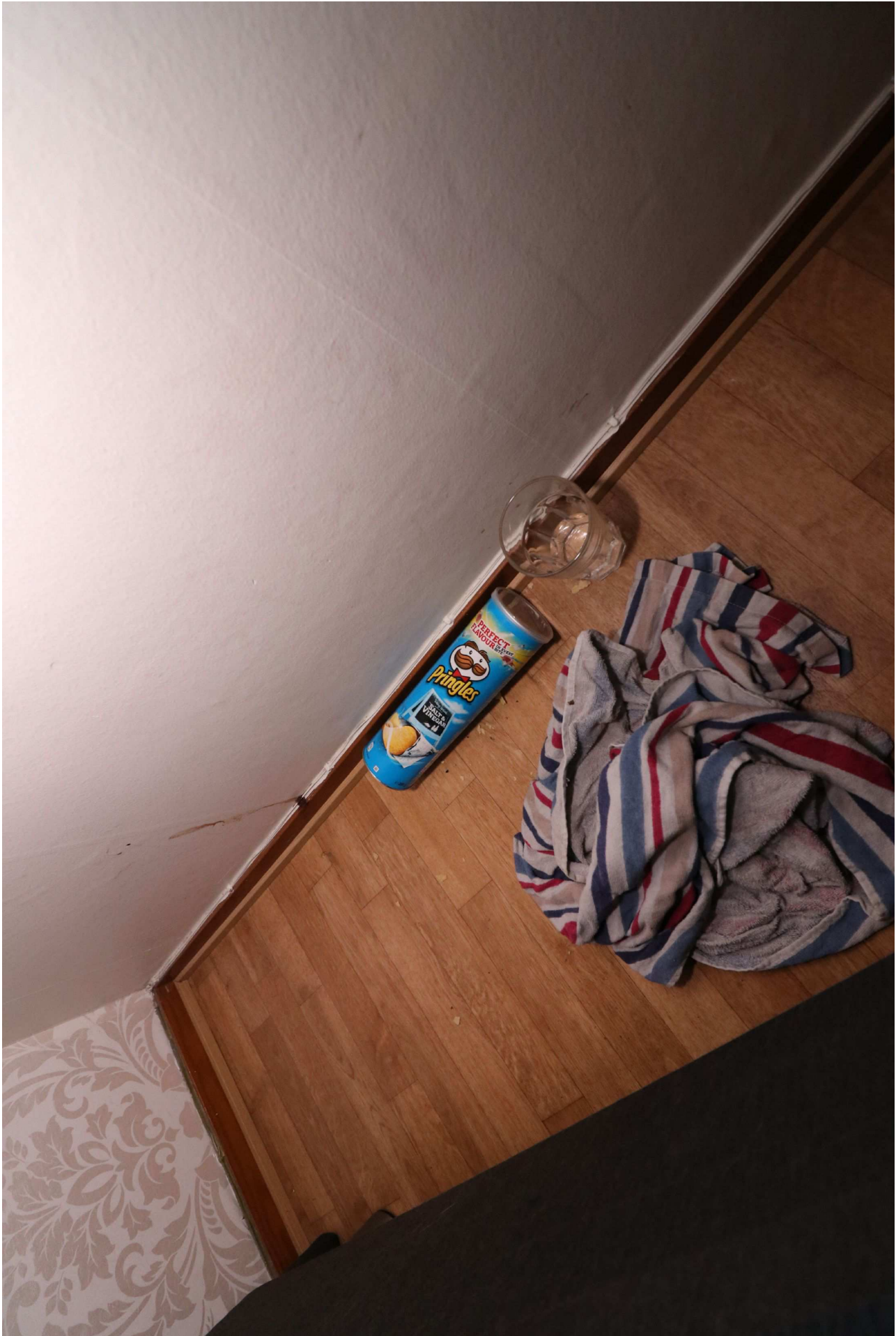
2. Sovrum. Eventuell blodbesudling på väggen. Platsundersökning 2020-08-31 av Kriminalteknikerna Peter Johansson och Thommy Scherman
