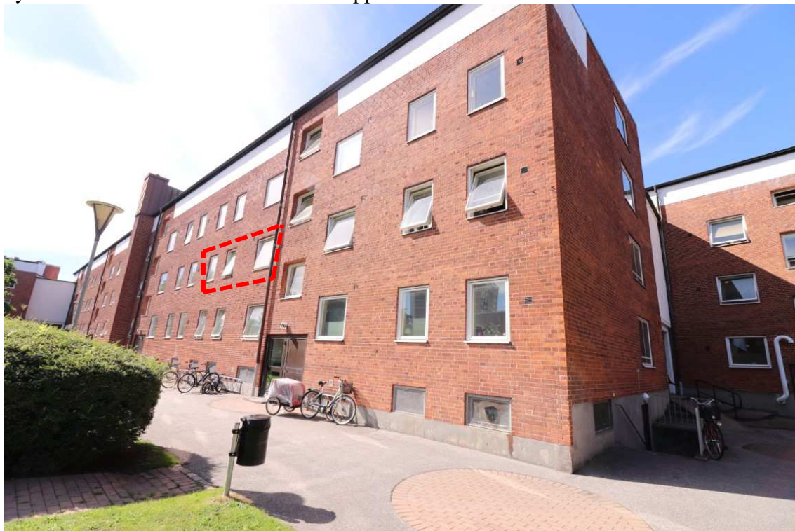
Figur 3: Fastighetens östra sida. Lägenhetsfönster markerade.
