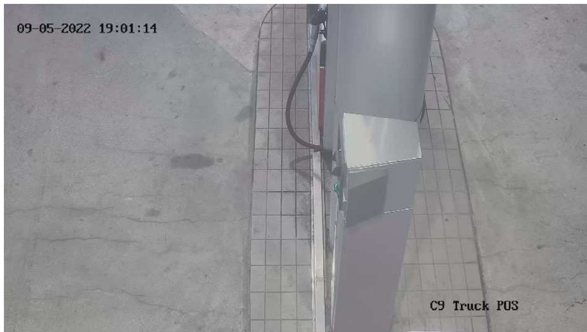
Pumpar mot Borrgatan.
