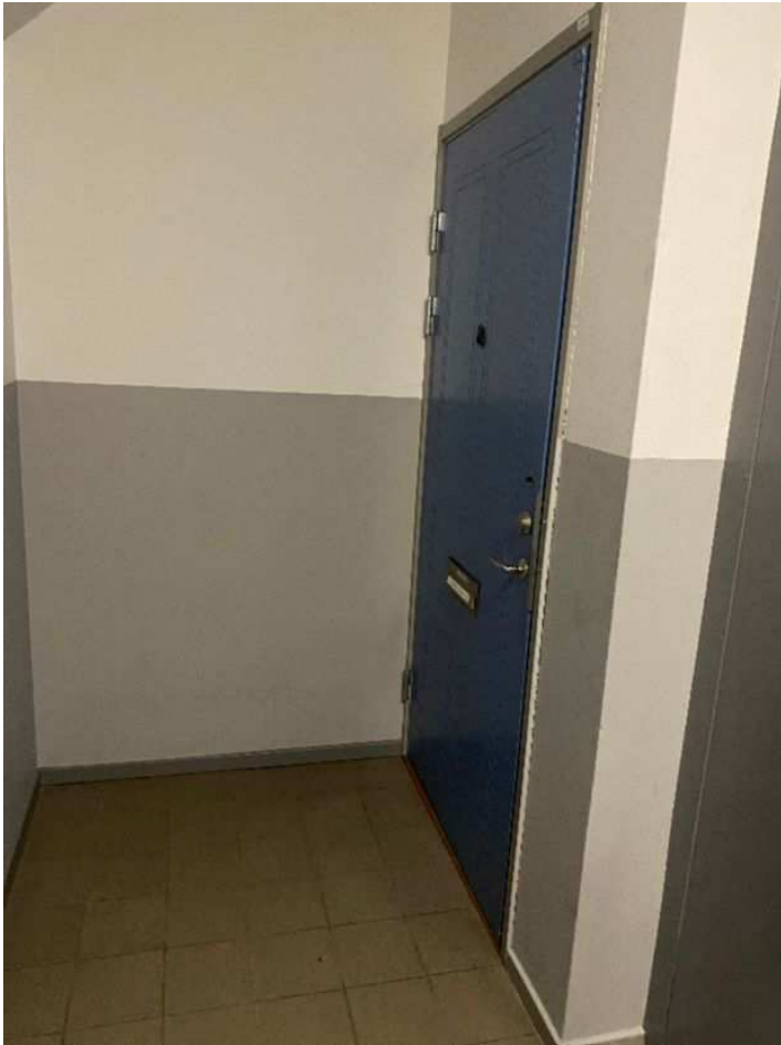
1. Foto över entrén till Kommisgatan 9 Lägenhet 1301.
