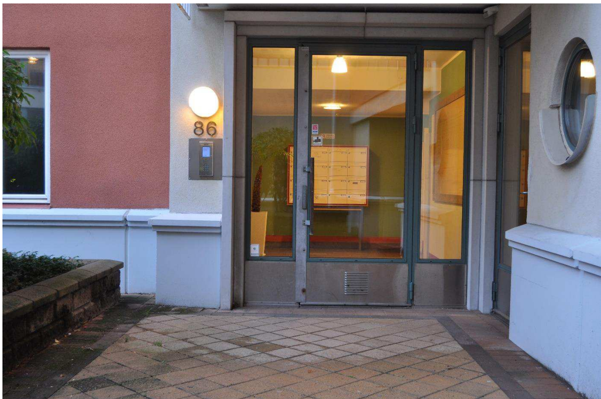
Bild 4. Aktuell trapphusentré. Portlåset till vänster i närbild i bild 5.
