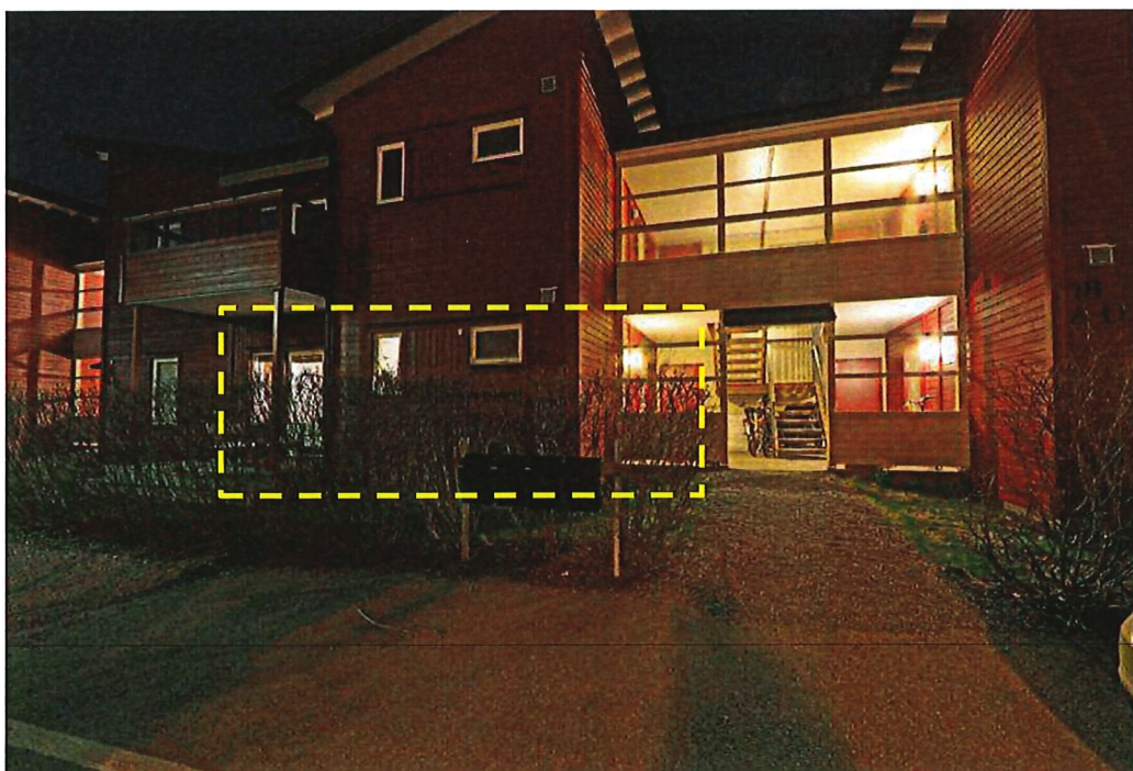
Figur 2. Översiktsbild på utsidan av den aktuella lägenheten. Den gula streckade rektangeln visar den aktuella lägenheten samt dörren in till förrådet.
