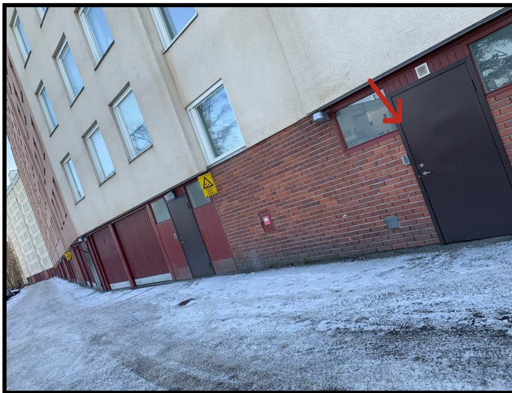
Bild 6 Den röda pilmarkeringen visar entrédörren till bastun på Sikvägen 31. 41 Omnämns i inpasseringsloggen som enhet KL. 2:62: 42 43 44
