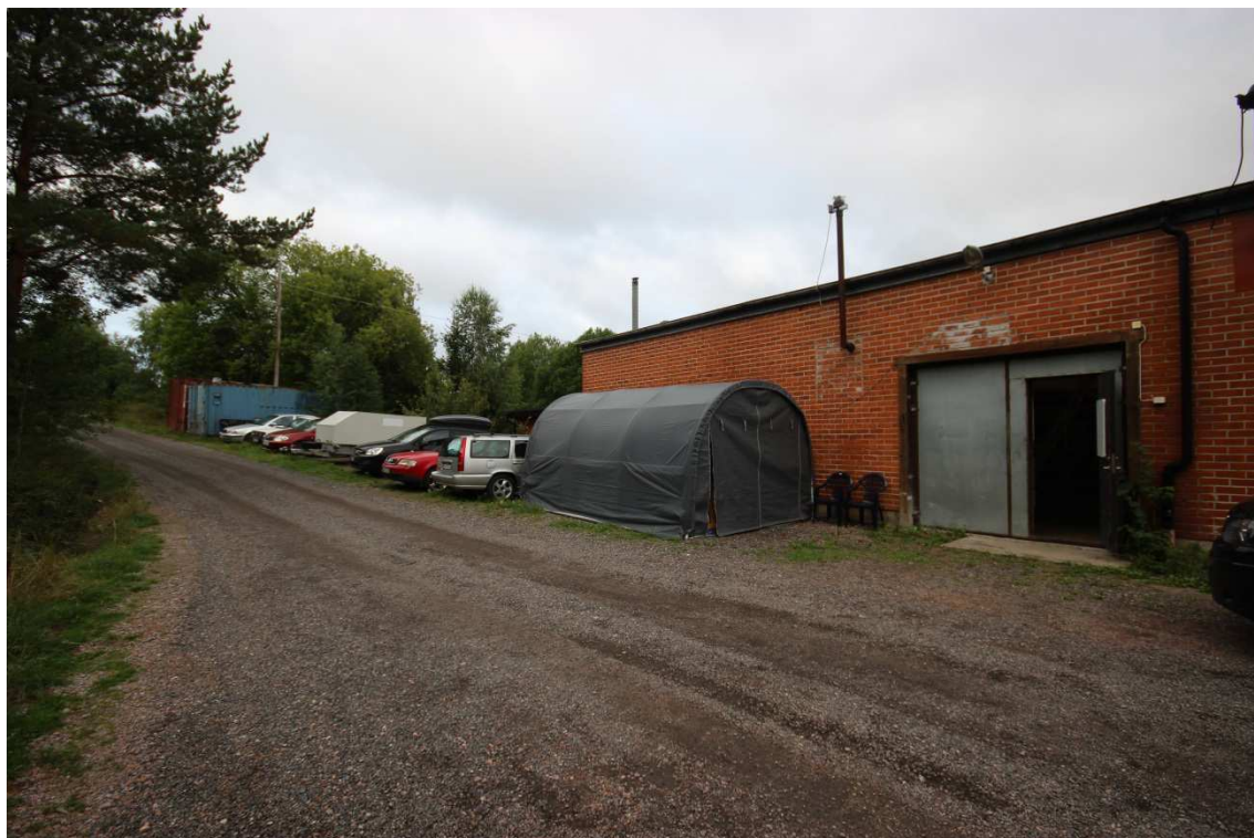
Bild 1. Ingången vetter mot sydost.
