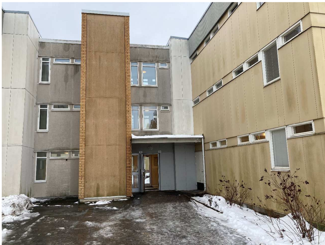
Figur 3. Entrén till Orrgränd 4B och 5B på fastighetens nordvästra sida.
