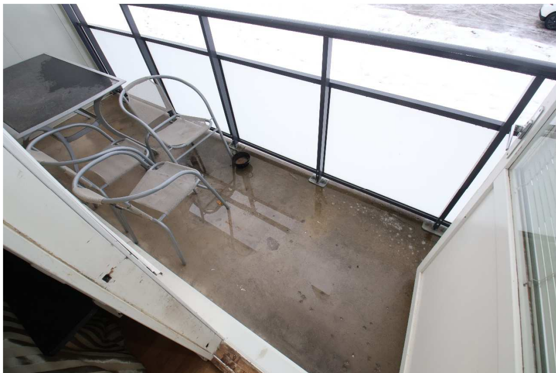
Figur 18. Balkongen. Vy från vardagsrummet.
