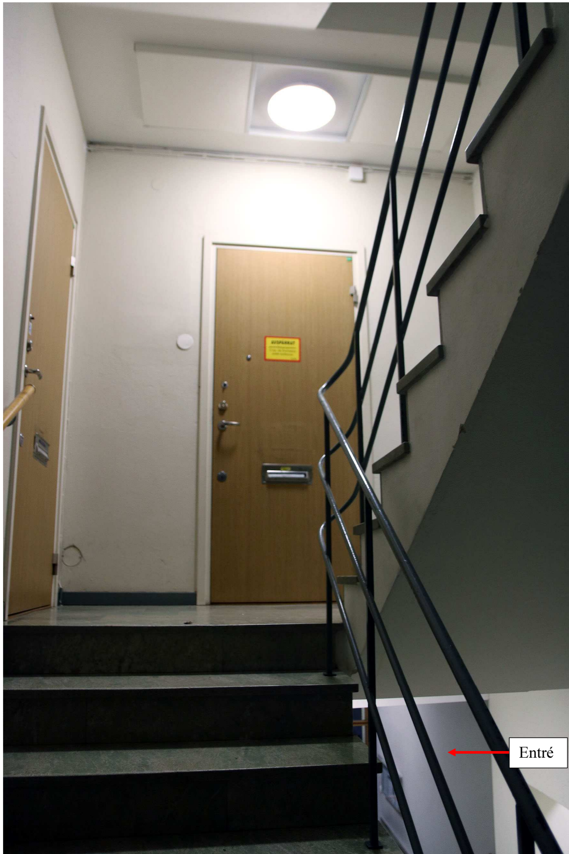
Figur 7. Trapphuset med den avspärrade lägenheten rakt fram.
