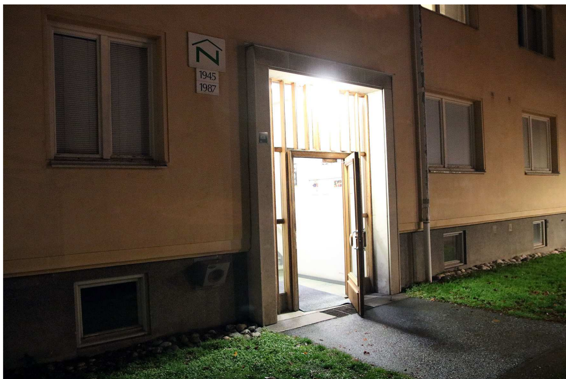
Figur 5. Entrén till Folkungavägen 8 B.
