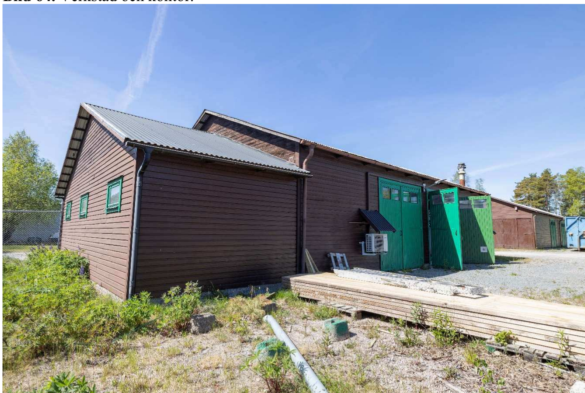
Bild 65. Baksidan av verkstads- och kontorsbyggnaden.
