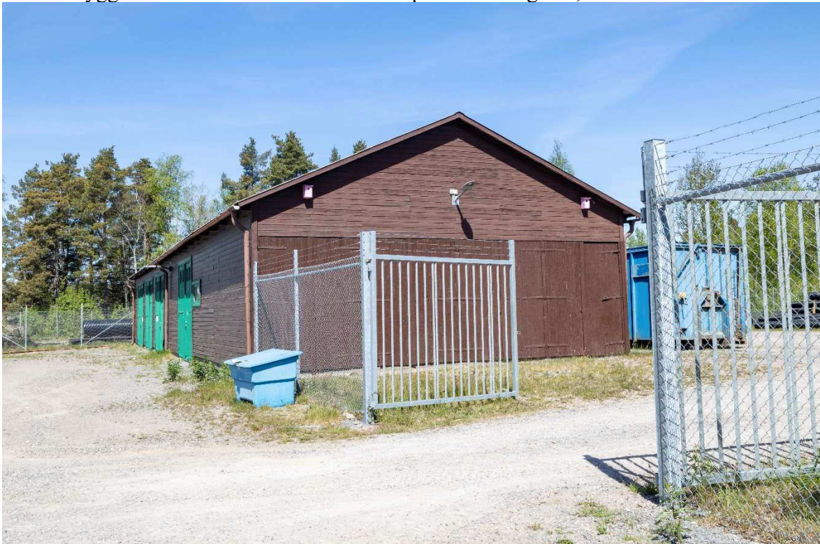
Bild 2. Förrådsbyggnad på Maskinvägen 1, Laxå.
