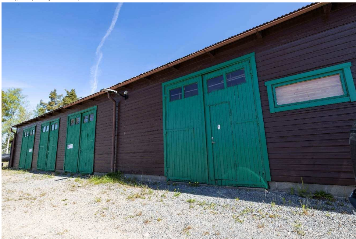
Bild 43. "PORT 1" (till höger i bild).
