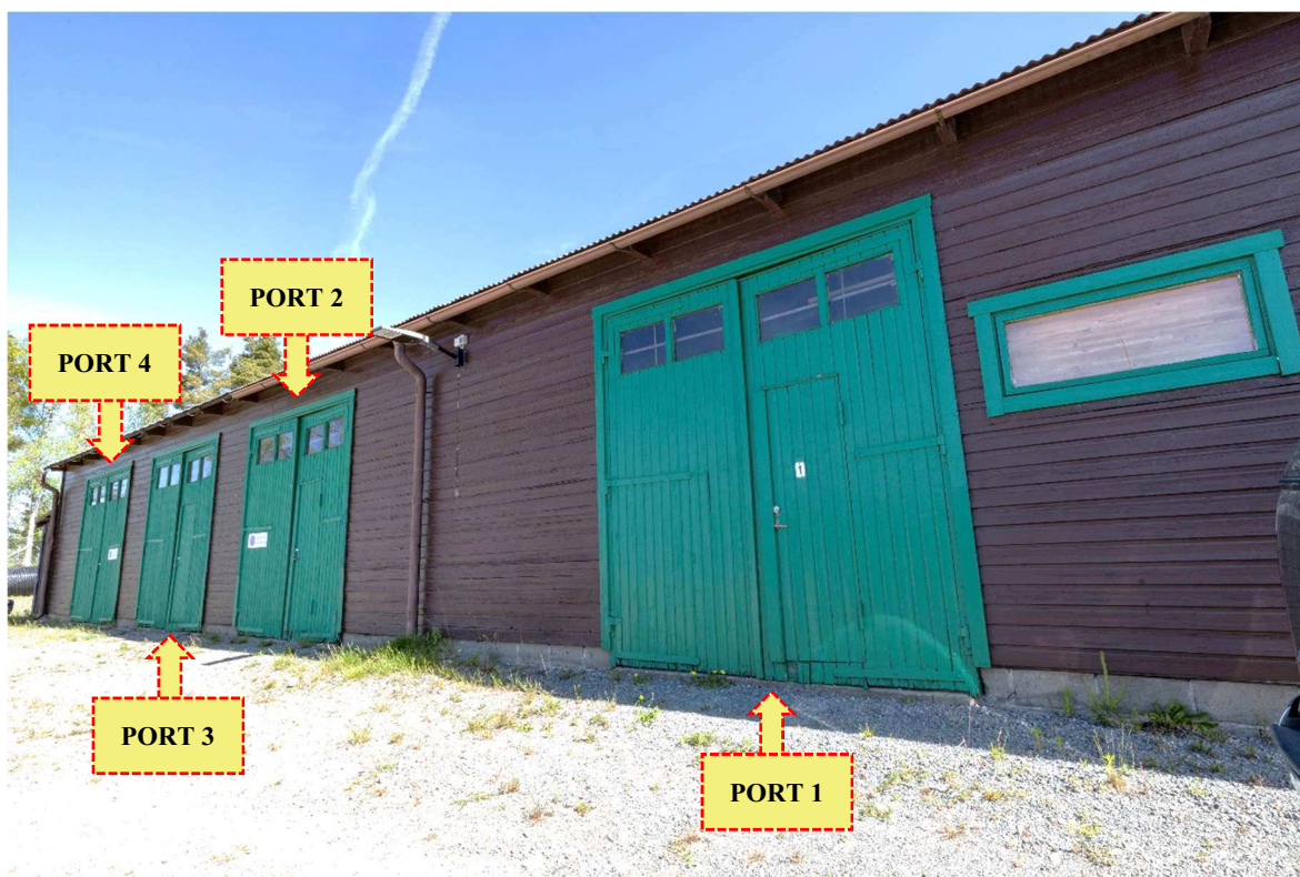
Bild 3. Förråd på Maskinvägen 1, Laxå. De olika förrådsytorna benämns som "PORT 1", "PORT 2", osv. enligt bild ovan.
