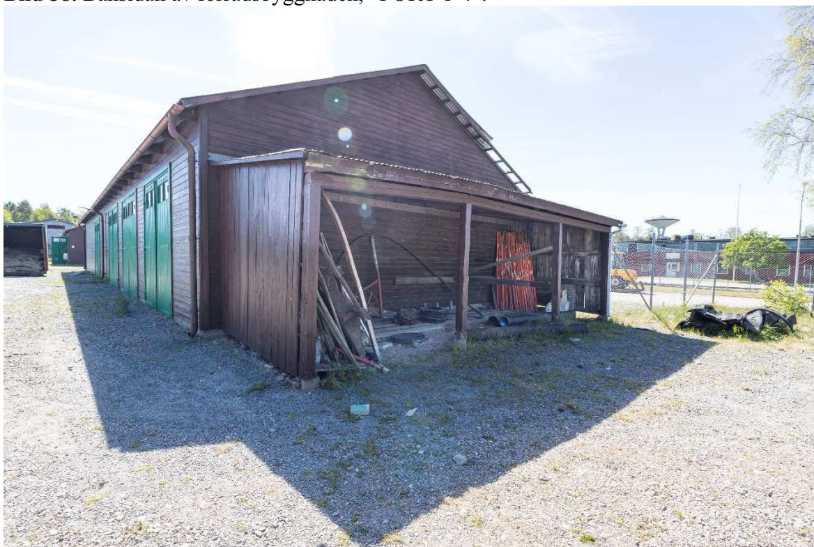
Bild 59. Baksidan av förrådsbyggnaden.
