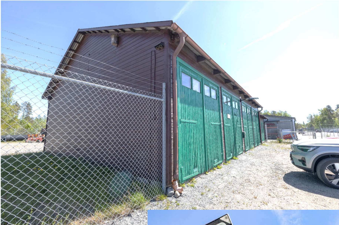
Bild 62. Byggnad för verkstad samt kontor.
