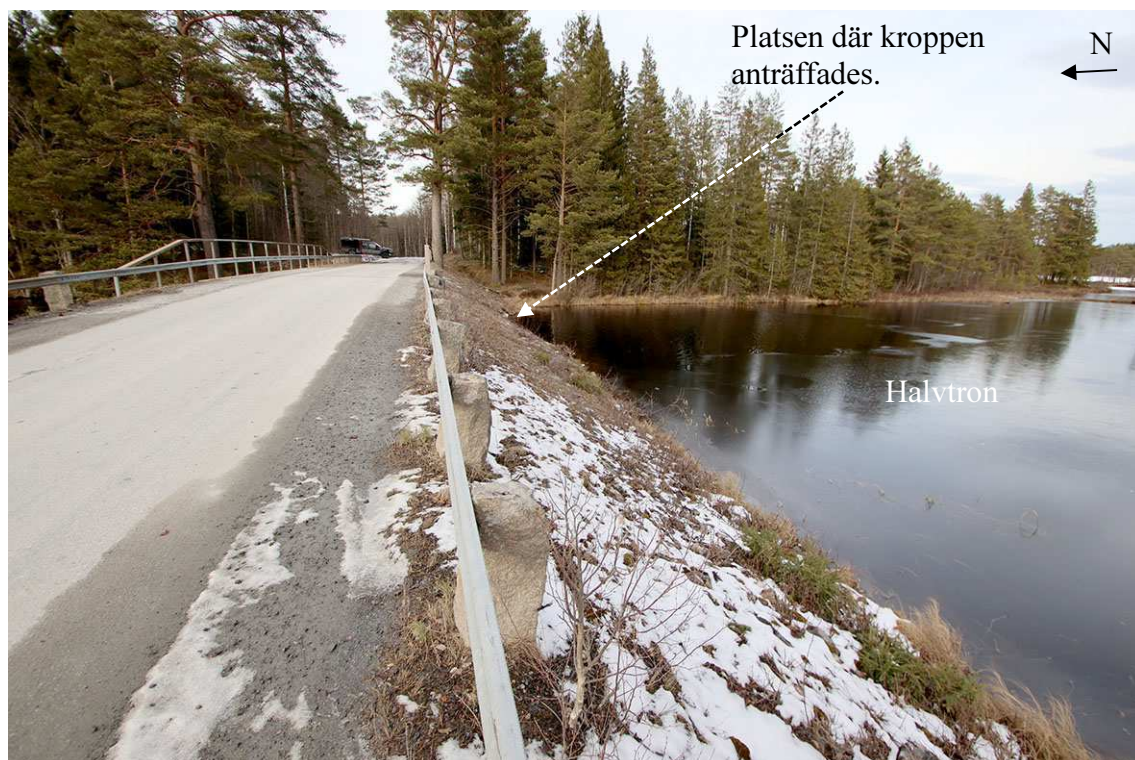
Figur 15. Bilden visar bron i riktning mot nordost.
