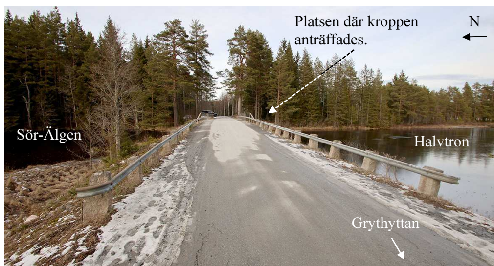
Figur 14. Bilden visar bron i riktning mot nordost.
