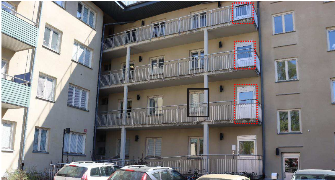
Figur 6. Olåsta branddörrar som leder till Kungsgatan 36B, markerade med röd streckade rutor. På bilden ses också loftgångar som leder till branddörrar belägna i inre hörnet som leder till Kungsgatan 36A och Bondegatan 12. Fönster till Saga Elneborgs lägenhet är markerat med en svart ruta.
