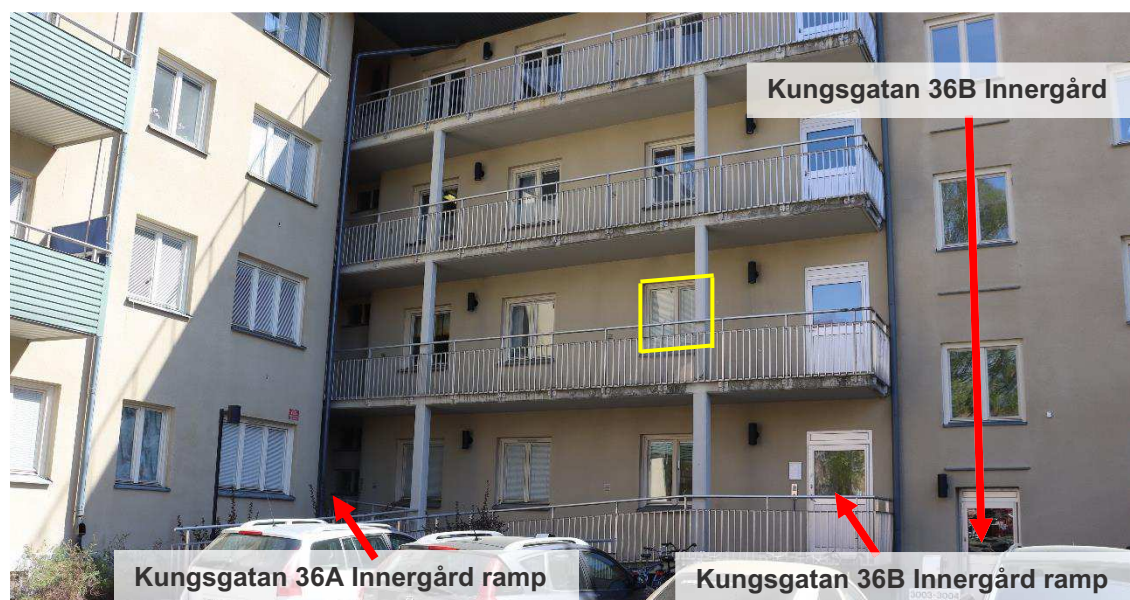
Figur 4. Foto på baksidan av Kungsgatan 36A-B och Bondegatan 12. En gul ruta markerar köksfönstret tillhörande den undersökta lägenheten. Röda pilar markerar entrédörrar till trapphusen på Kungsgatan 36A och Kungsgatan 36B/Bondegatan 12.
