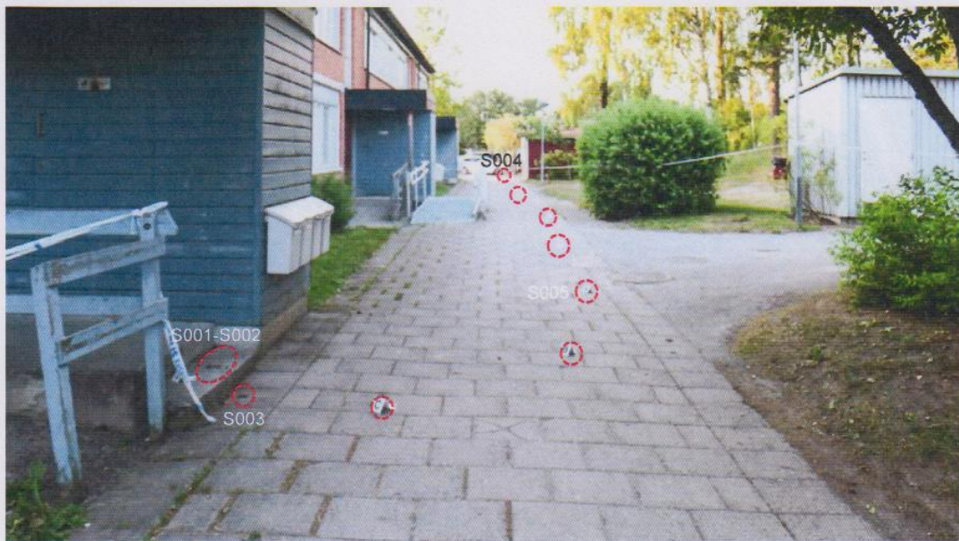
Bild 12. Gång/cykelbanan öster om Författargatan 23 sedd i riktning mot norr.
