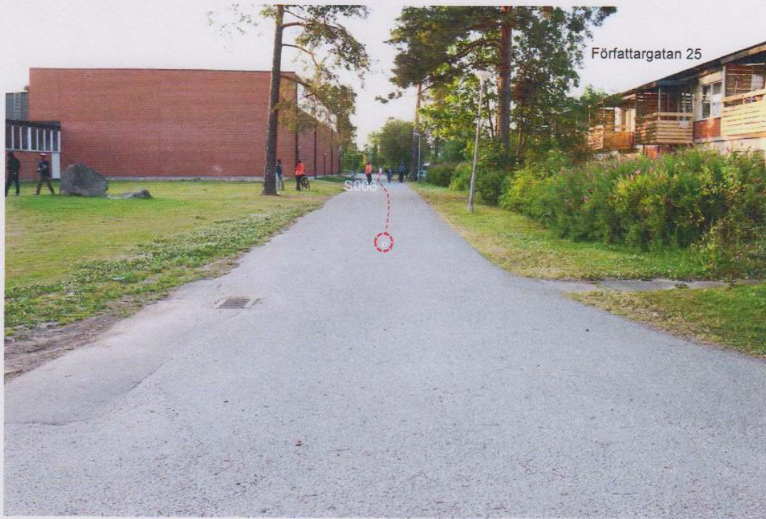
Bild 13. Gång/cykelbanan väster om Författargatan 25 sedd i riktning mot norr.
