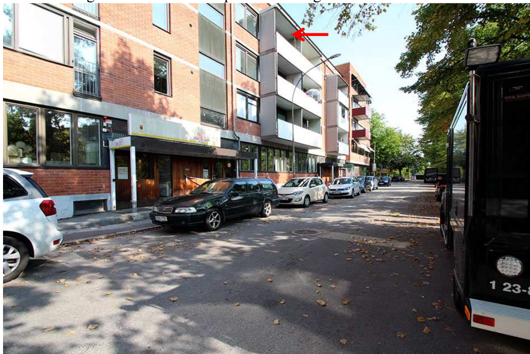
Figur 2. Den röda pilen pekar på balkongen till den avspärrade lägenheten.
