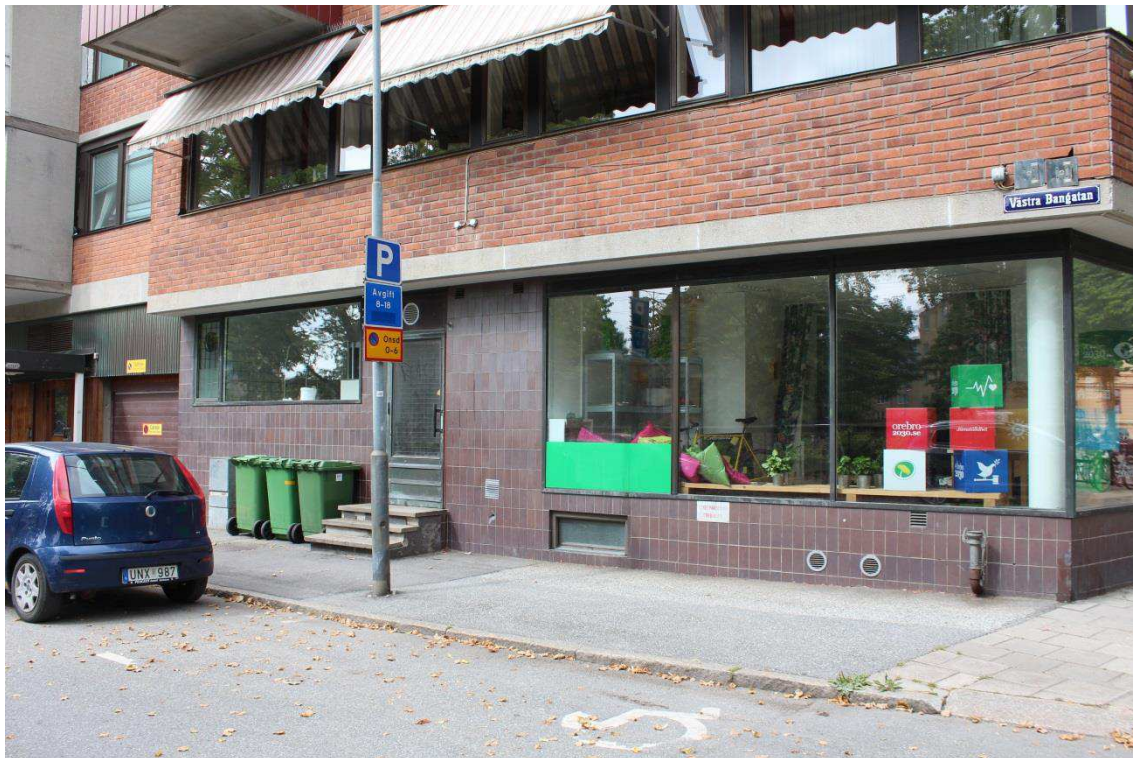
Västra Bangatan med soptunnorna utmed fasaden.
