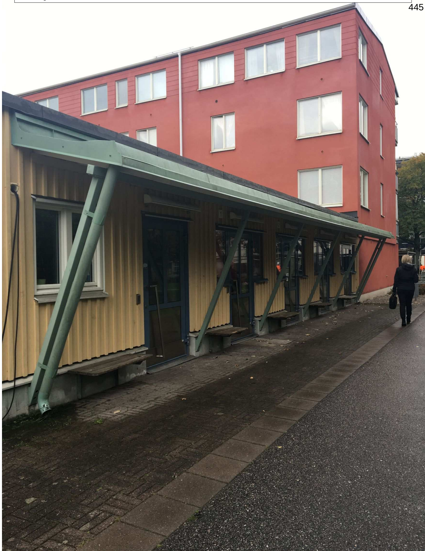
Bild tagen på kortsidan av Örnköldsgatan 77 där tvättstugorna är belägna. Ett vittne har suttit på någon utav bänkarna vid tillfället för brotten. Bild tagen av F. Öhman 20181002.
