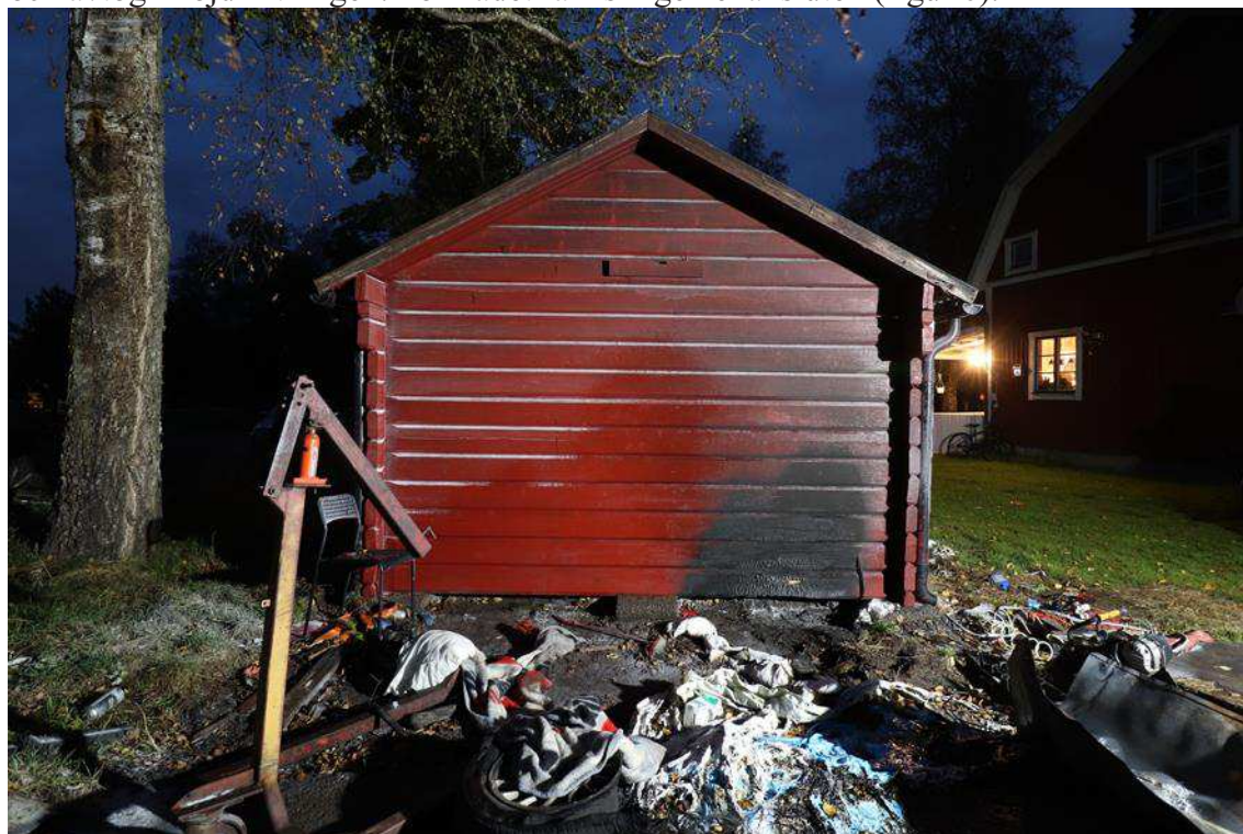
Figur 6. Östra gaveln av friggeboden och brandområdet.
