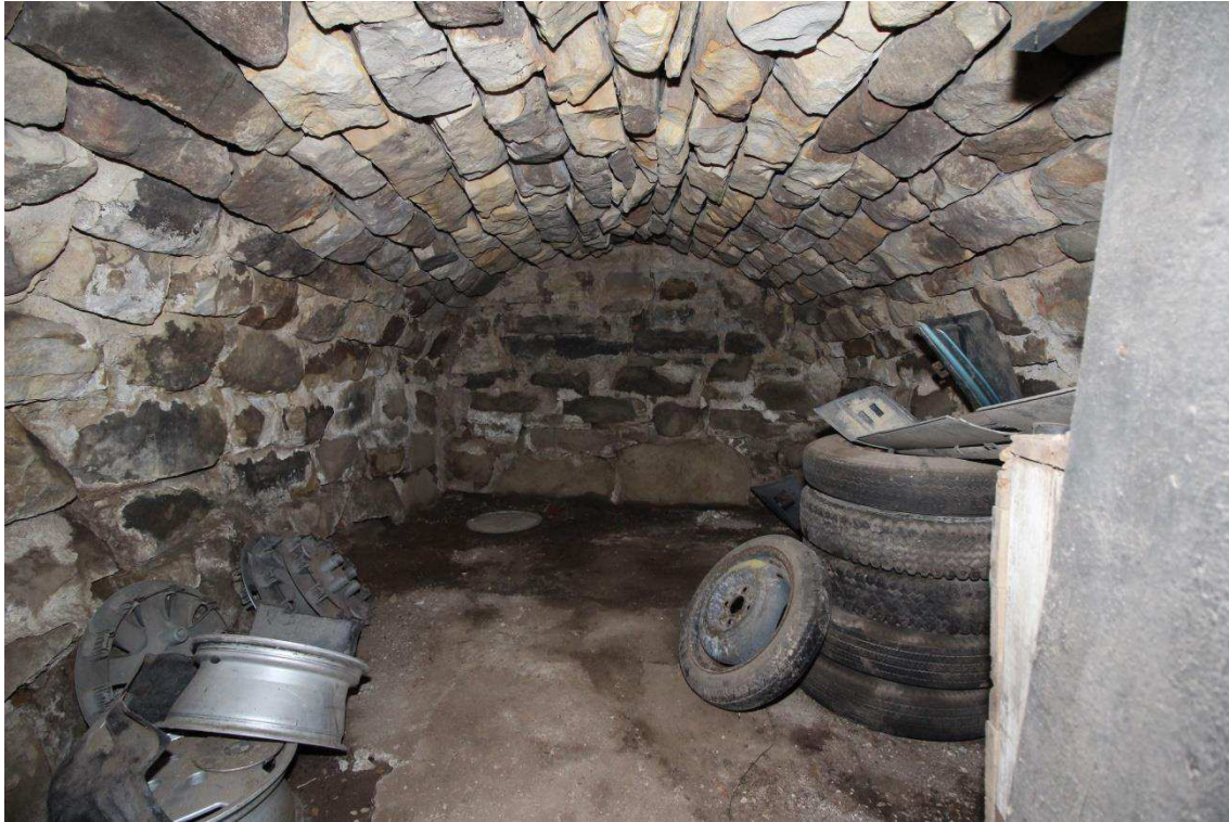
Bild 22. Foto från entrén in i jordkällaren.
