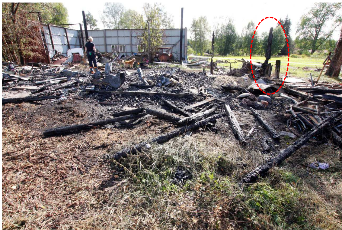
Figur 4. Byggnaden var förintad av totalbrand bortsett från en del av en träregel och några få panelbrädor återstod, i bilden markerade med röstreckad ellips.
