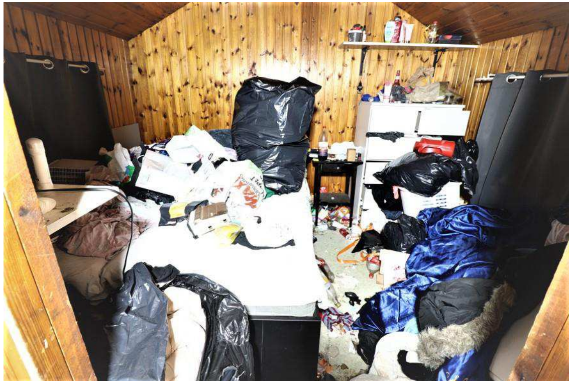
Figur 9. Översiktsbild av insidan av friggeboden.
