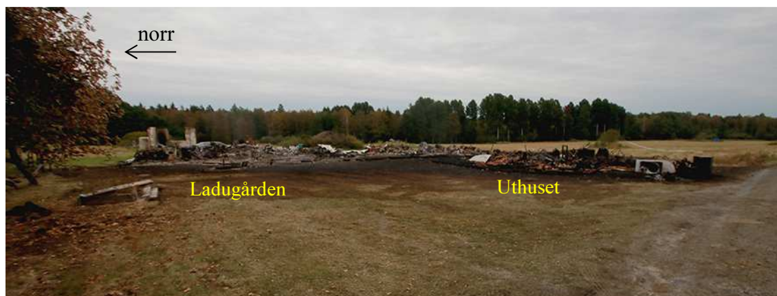
Bild 5. De nedbrända byggnaderna dokumenterade från vägen.
