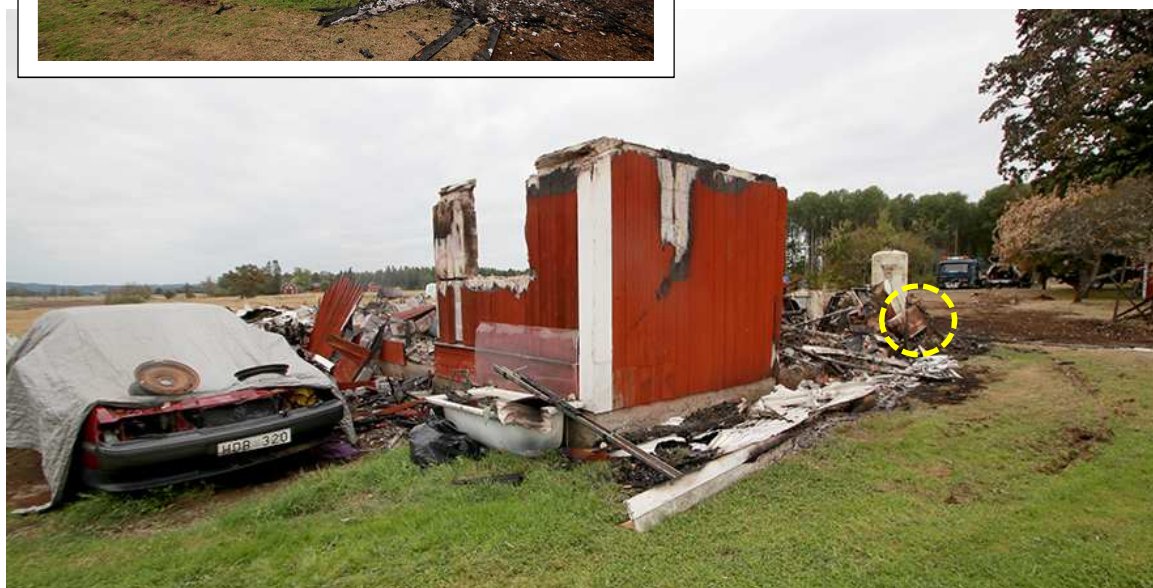
Bild 6. Ladugårdens nordöstra hörn med delar av ytterväggen kvar. I bilderna är elskåpet markerat.
