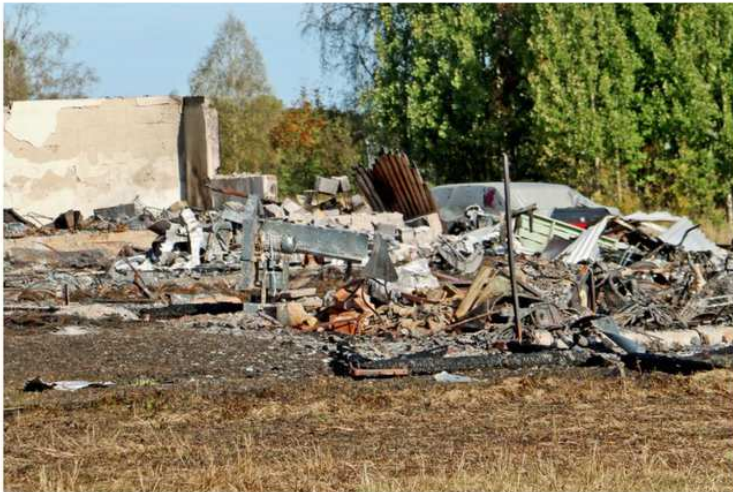
Två byggnader brann ner på en gård norr om Vretstorp den 17 september 2021. Bild: Jan Wijk
