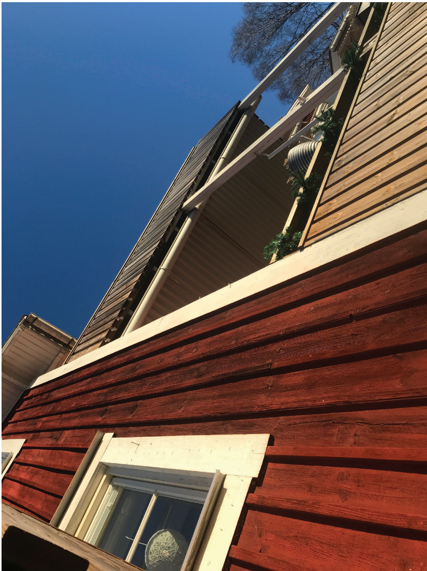
4. Sikten i dagsljus från trappen ner till tvättstugan rakt upp mot målsägandes lägenhetsbalkong.
