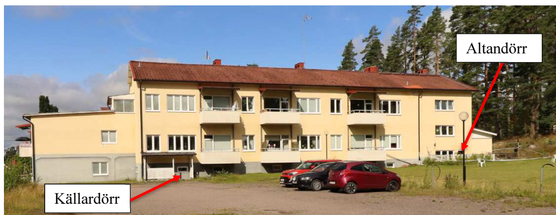
Figur 5: Byggnadens baksida sett från parkeringen. Pilar med textrutor markerar källardörren och altandörren.
