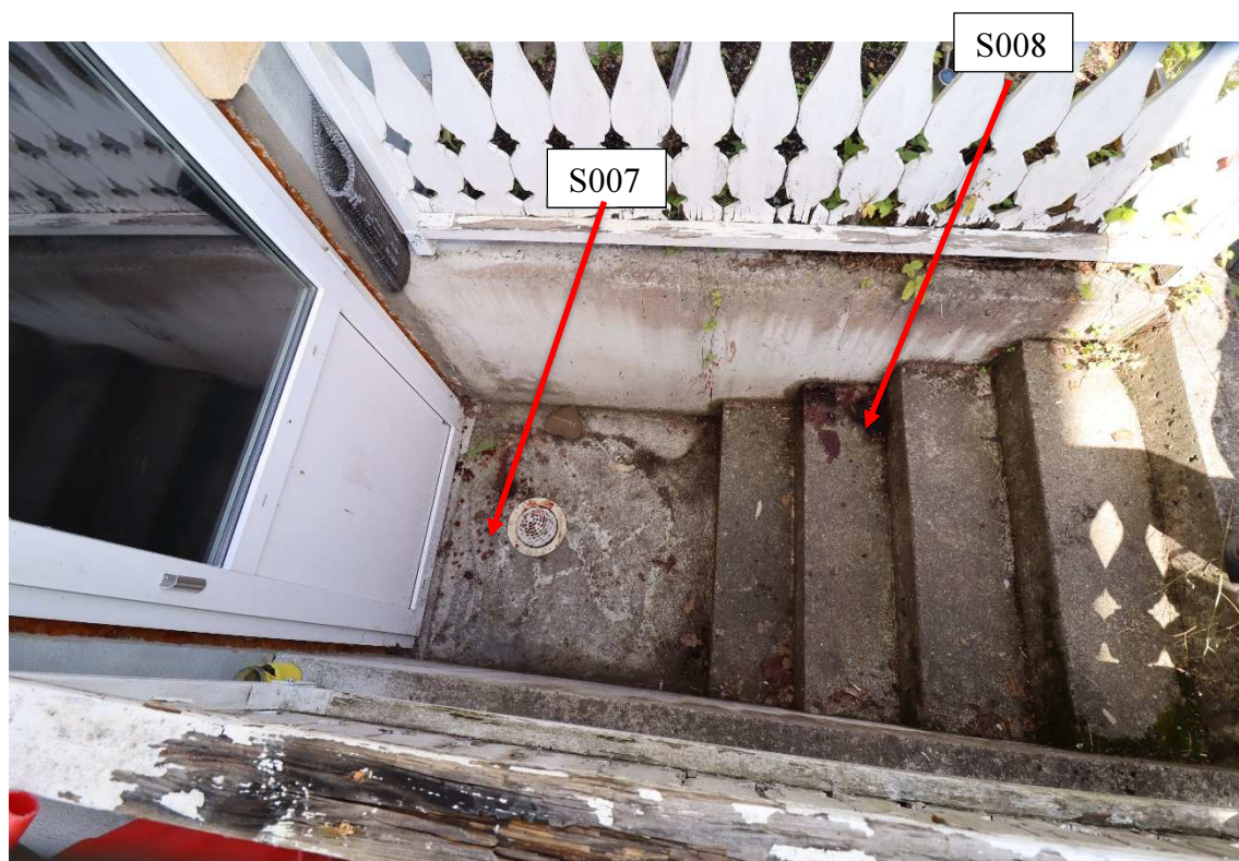
Figur 14: Källartrappan vid uteplatsen på baksidan (östra sidan) av byggnaden. Med blod vid golvbrunnen och blodansamlingen på andra trappsteget sett nerifrån.
