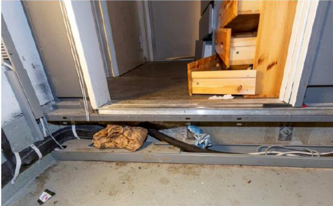
Figur 6. Hisschaktet. Utrymmet bakom plåten.
