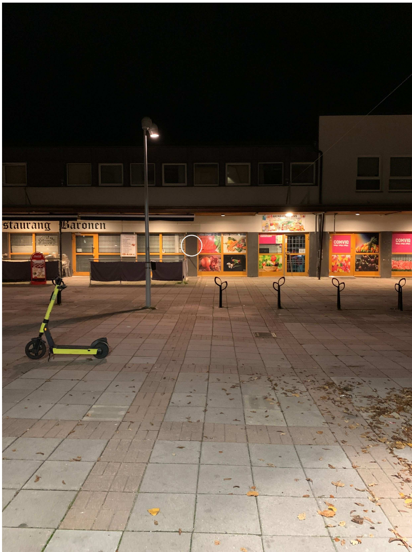
20. Bild från tunneln mot fasaden där det är inringat vart det misstänkta skothålet är.
