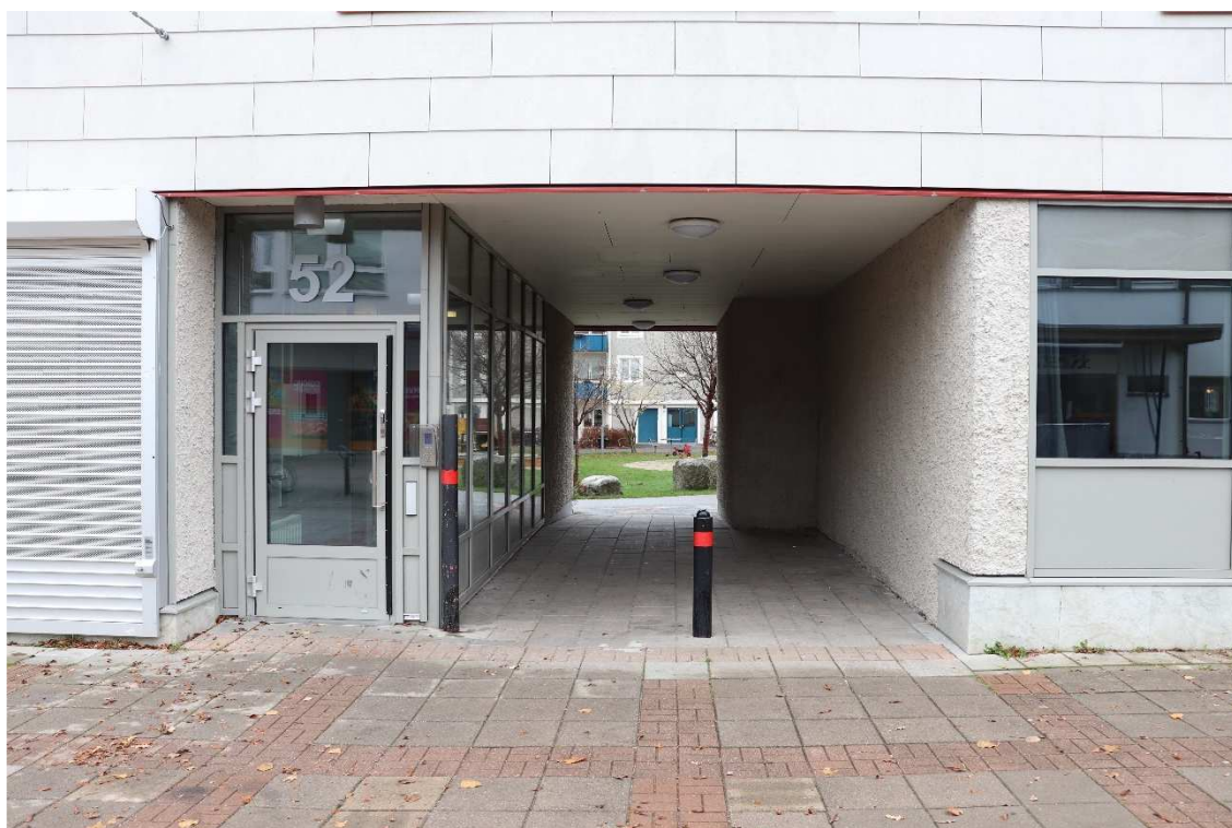
Figur 7. Översiktsbild av gångtunneln under höghus, mot innergård.
