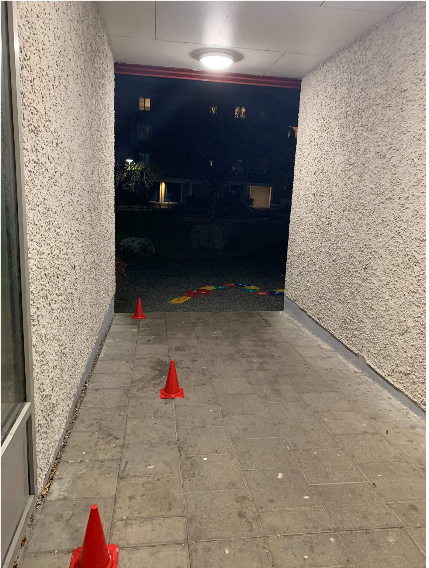
3. Bild på gångtunneln. Samtliga beslag uppmärkta med koner.
