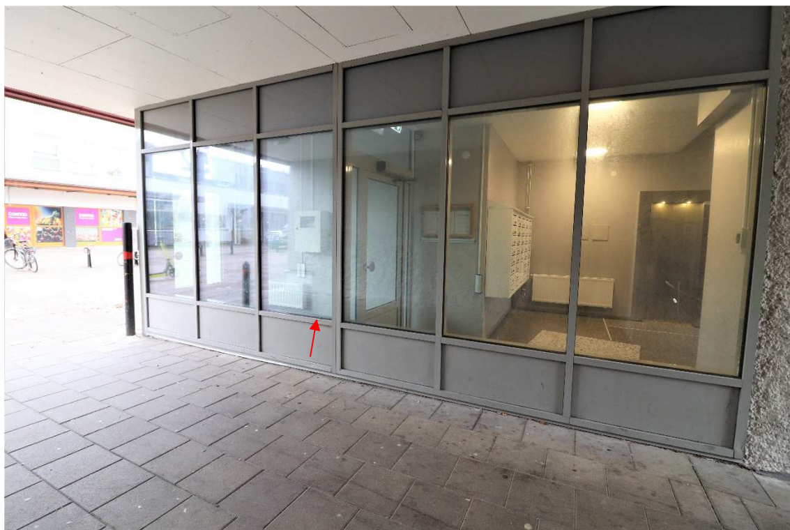
Figur 8. Översiktsskild av trapphuset. Pilen påvisar var en kula sågs. Kulan låg inne i en fönsterkassett.
