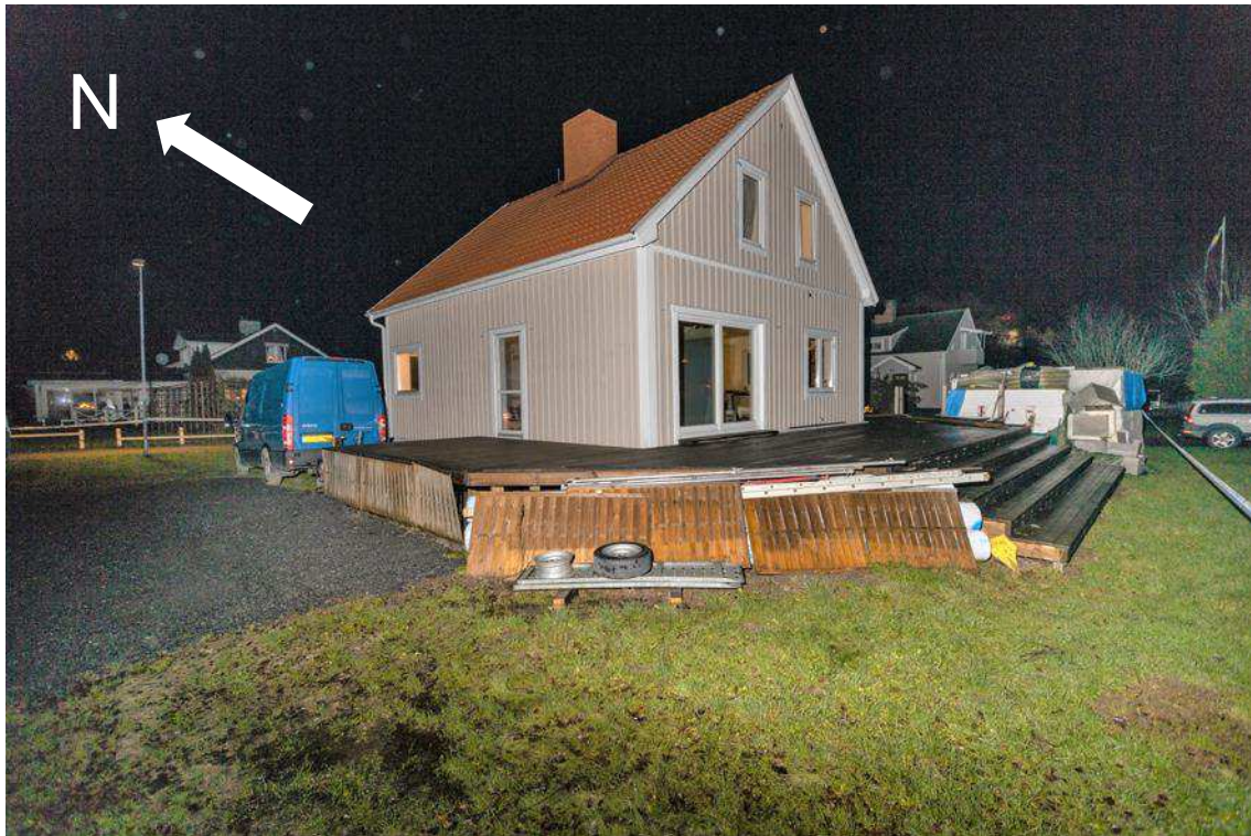
Figur 9. Fastighetens södra och västra fasad. Uteplatsen var utformad på så sätt att insyn mot amfetaminlabb i källaren inte var möjlig.
