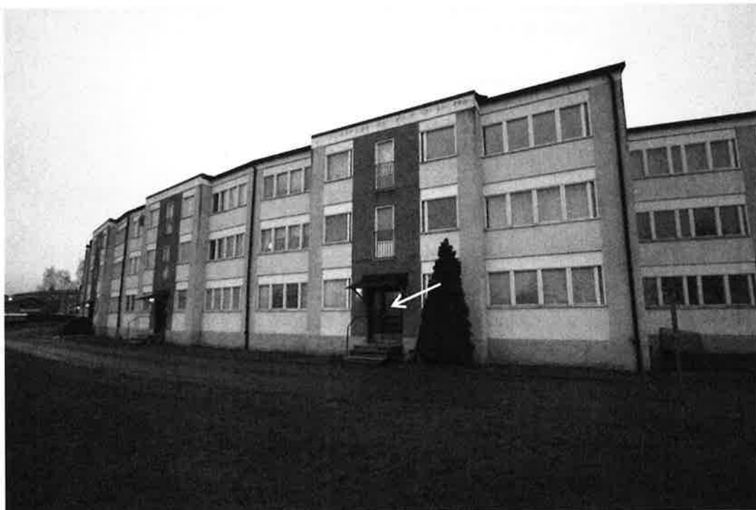
Bild 1. Pilen markerar entrén till ██████████ Bilden är fotograferad mot väster.
