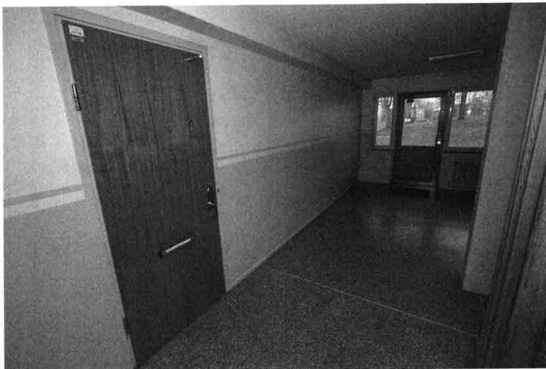
Bild 2. Trapphuset på källarvåningen med den aktuella lägenheten till vänster i bild och entrén från innergården rakt fram.
