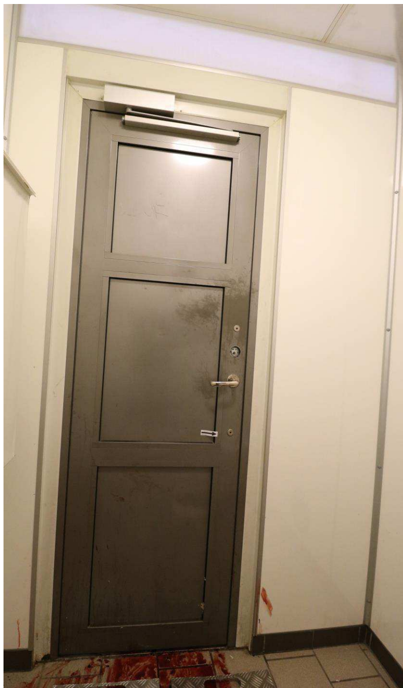
Figur 20. Den östra väggen med dörrens insida.
