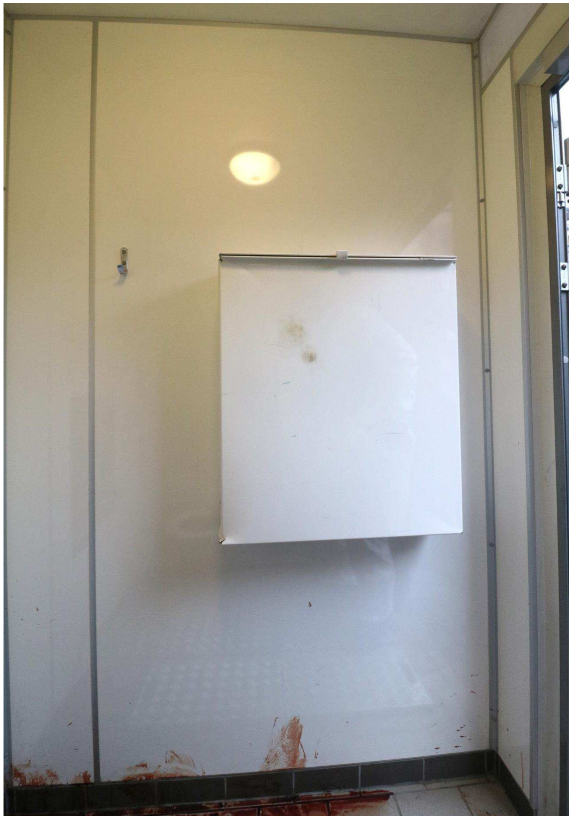
Figur 17. Översiktsbild av den norra väggen.
