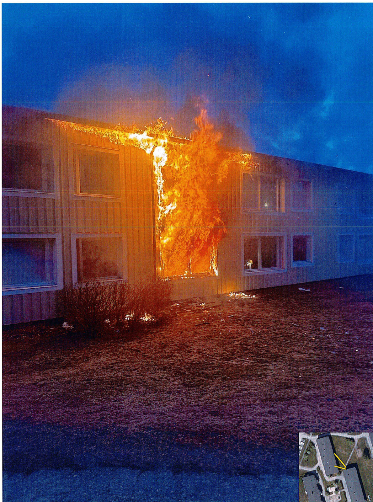
Figur 7 visar lågor på baksida på branddrabbad byggnad. Foto taget av ambulanspersonal kl. 20:33 strax innan räddningstjänstens framkomst.
