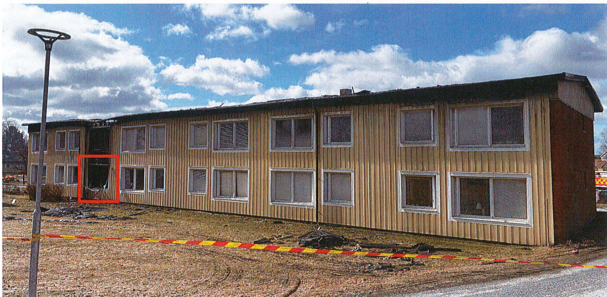
Figur 2 visar fasad på baksidan av branddrabbad byggnad. Fönster tillhörande aktuell lägenhet markerad med röd ram. Foto taget av undertecknad vid platsbesök 2025-04-09.
