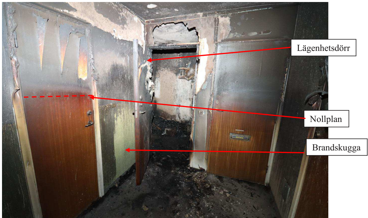
Figur 11. Översiktsbild markplan i trapphus tillhörande Solbacken 2C. I bilden är lägenhetsdörren, nollplan och brandskugga markerat med pilar.
