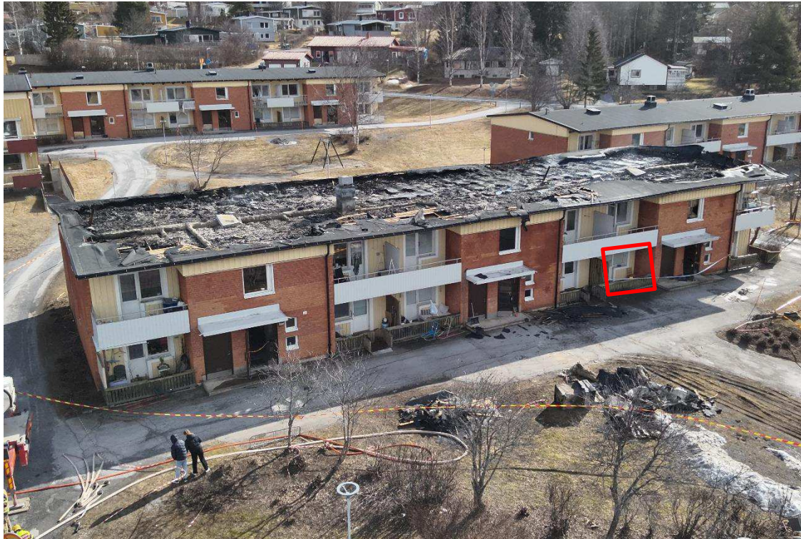
Figur 7. Bilden visar taket på Solbacken 2 Strömsund, framsidan/entré. Aktuell lägenhet markerad med röd rektangel i bild (UAS-bild från FILIP).
