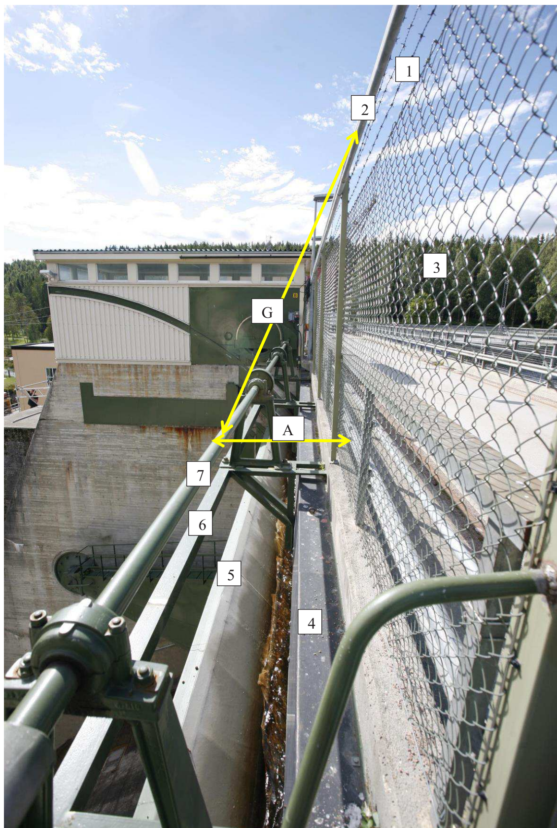
Figur 3. Utanför stängslet syns toppen på dammluckan (utskov) med vatten innanför mot brosidan.
