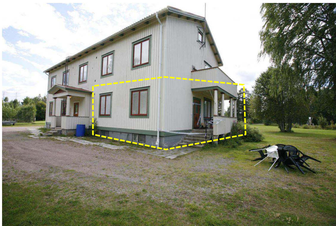
Figur 2. Den östra sidan och norra gaveln av aktuell fastighet, med adress Utanede 253 i Bispgården, Ragunda kommun. Aktuell bostad är belägen inom det inringade området.
