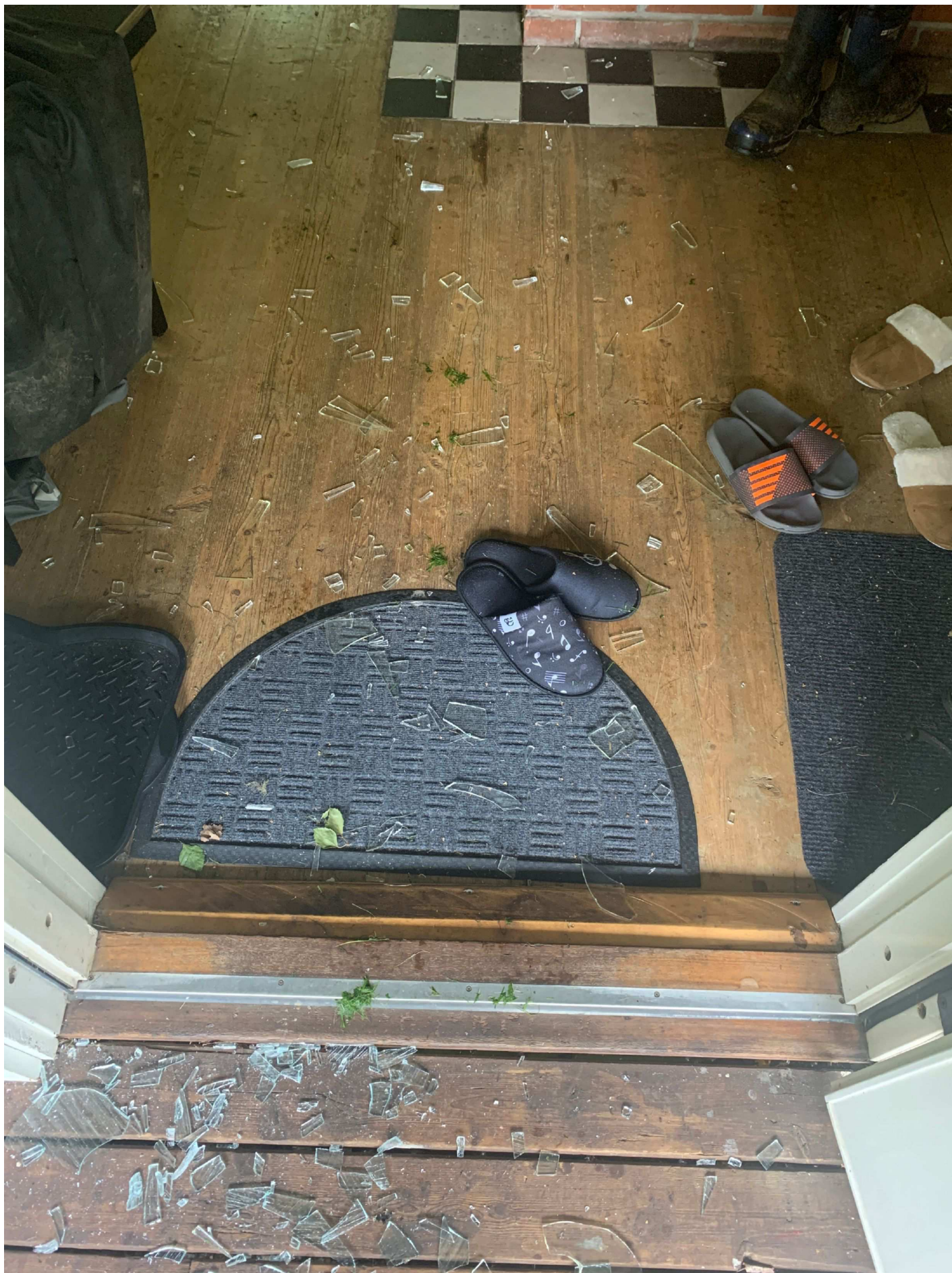
12. Golvet i hallen.
