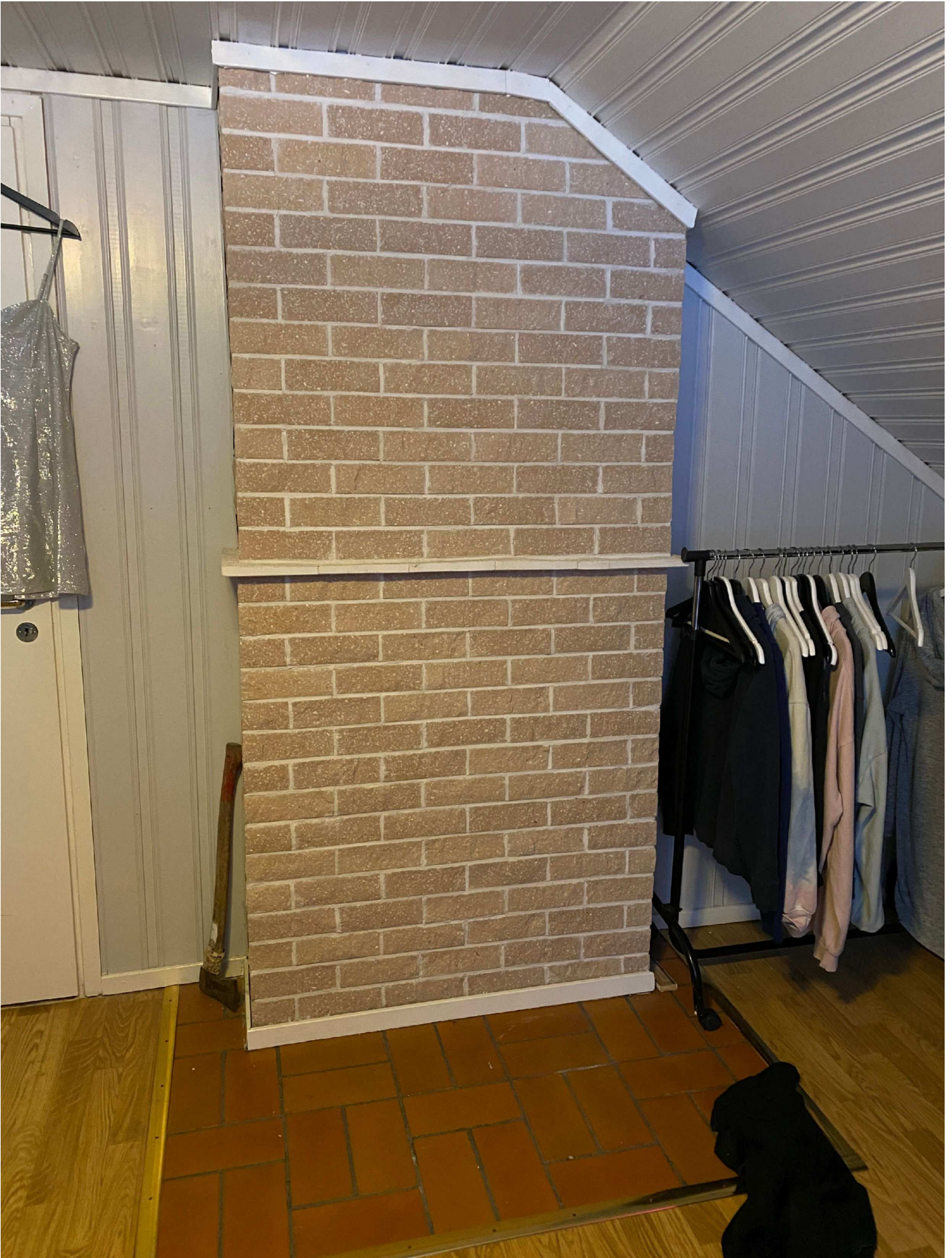
24. Murstock i sovrummet på ovanvåningen
