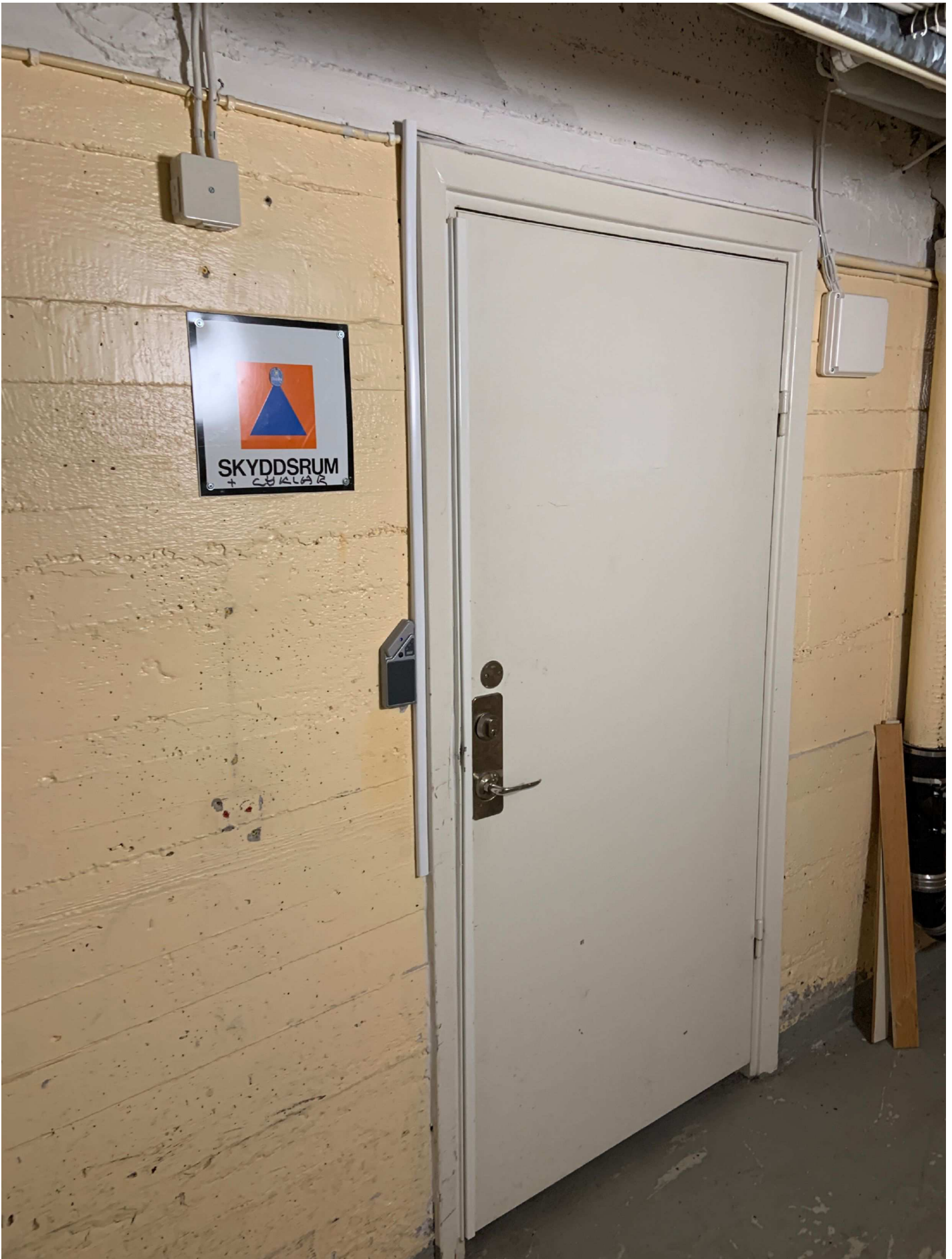
2. Dörr från källarkorridor in till skyddsrum.
