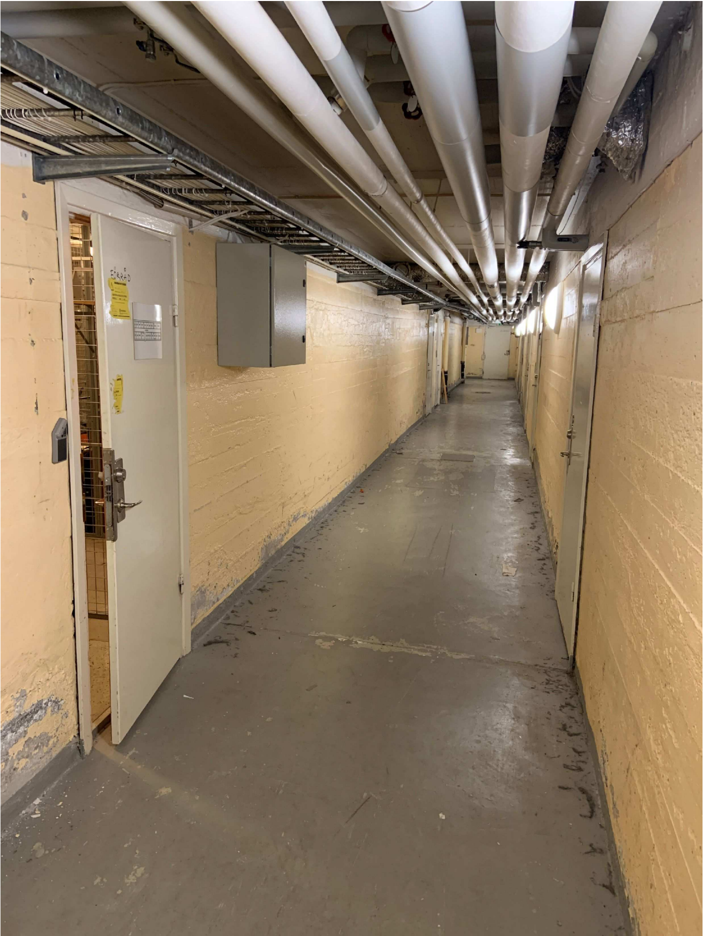
1. Första öppna dörren går till förråd. Längre ner i korridoren finns en dörr till vänster som går till skyddsrummet.
