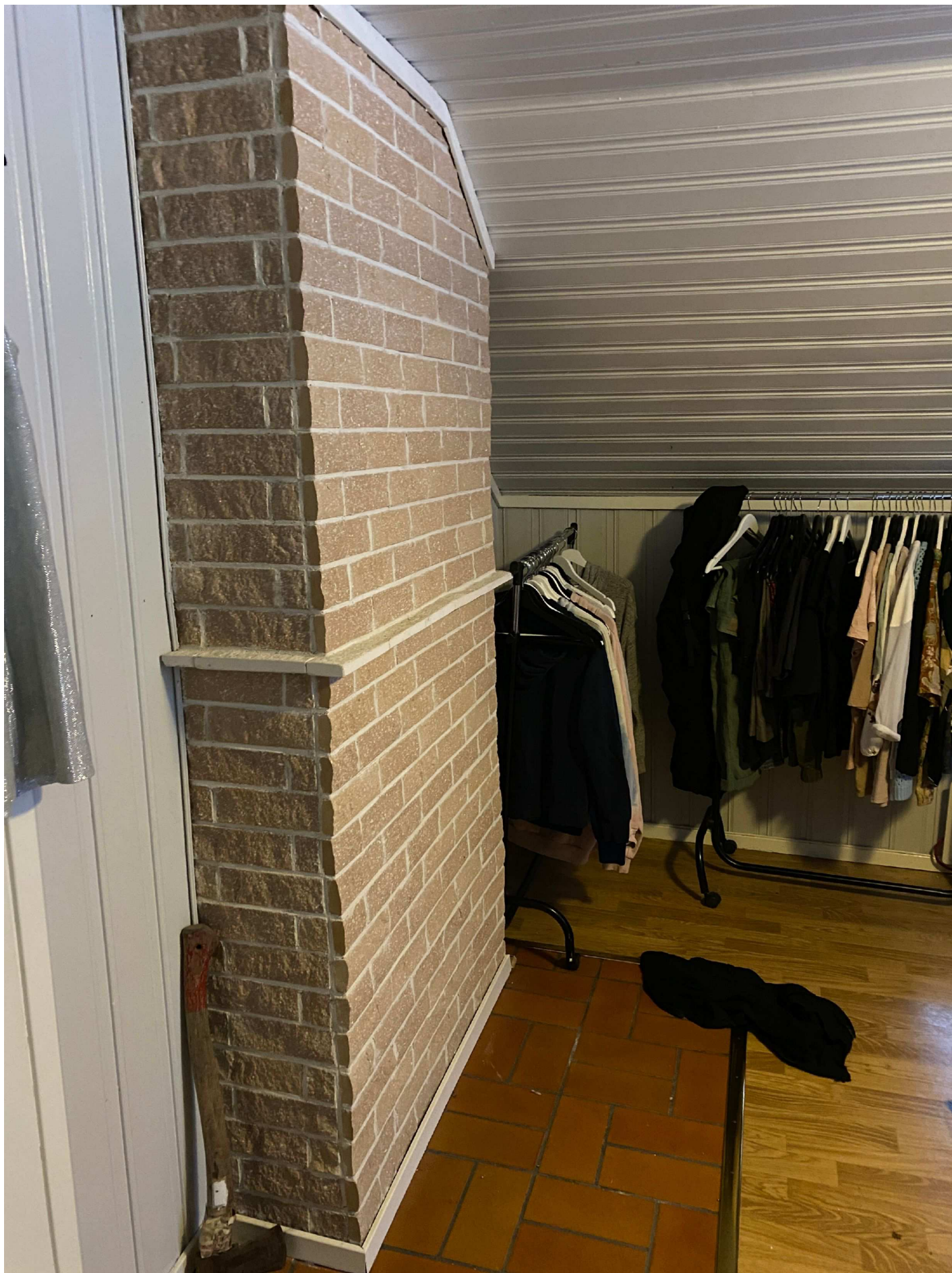
27. Murstock i sovrummet på ovanvåningen
