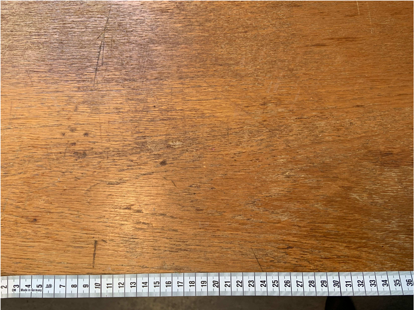
6. Bänkskiva under fönster. Skivans nedre högra sida. Måttband på nedre delen.
