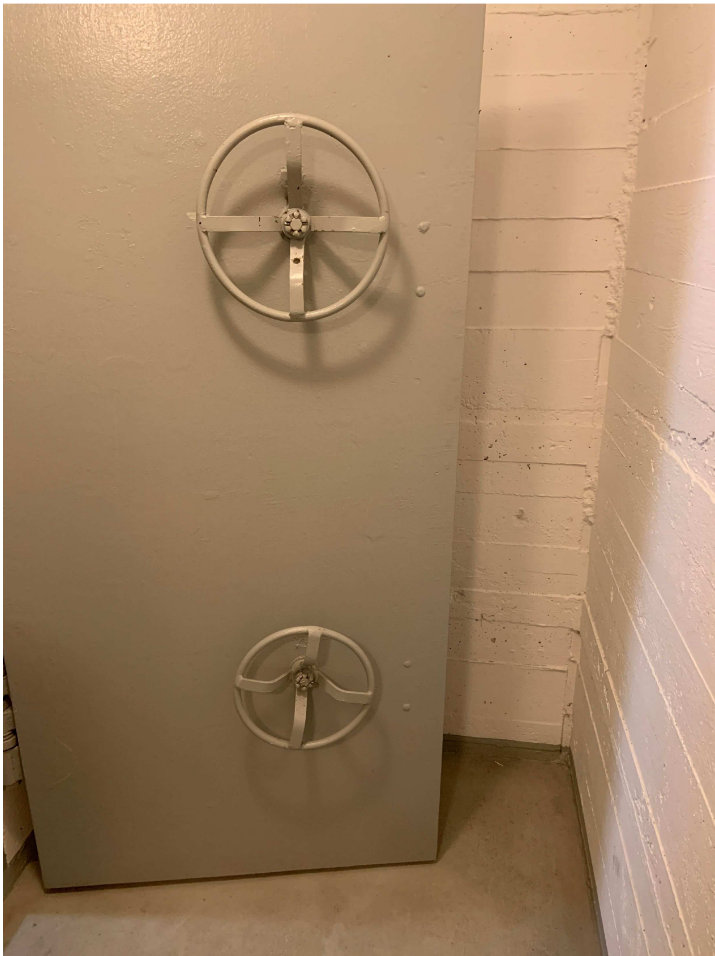
4. Inre dörr till skyddsrum. Bakom den hängde en tygpåse.
