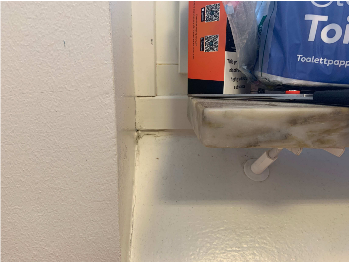
17. Fönsterbänk och detalj mot fönstret ovanför bänkskivan.
