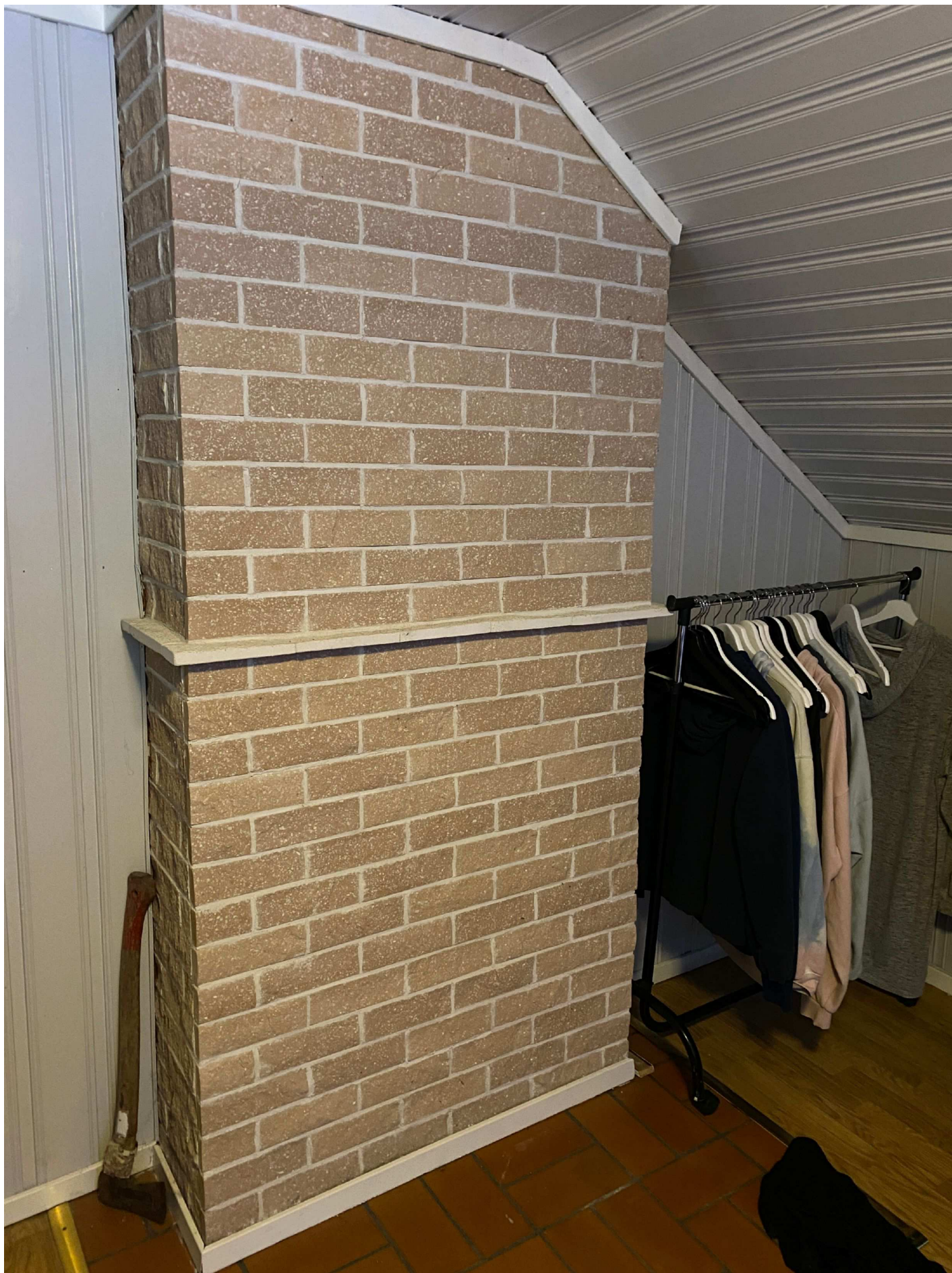
26. Murstock i sovrummet på ovanvåningen
