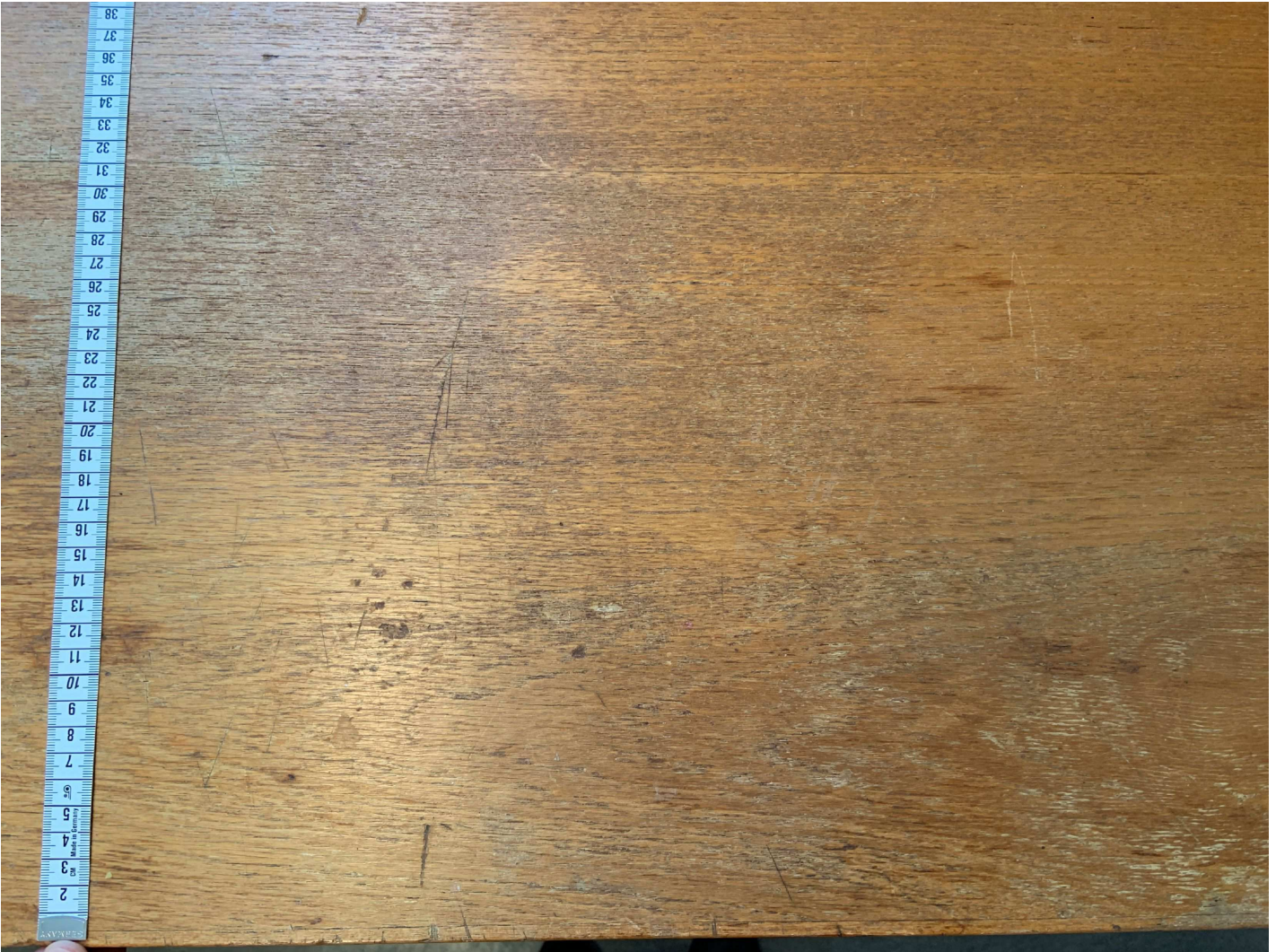
7. Bänkskiva under fönster. Skivans nedre högra sida. Måttband på vänstra sidan.
