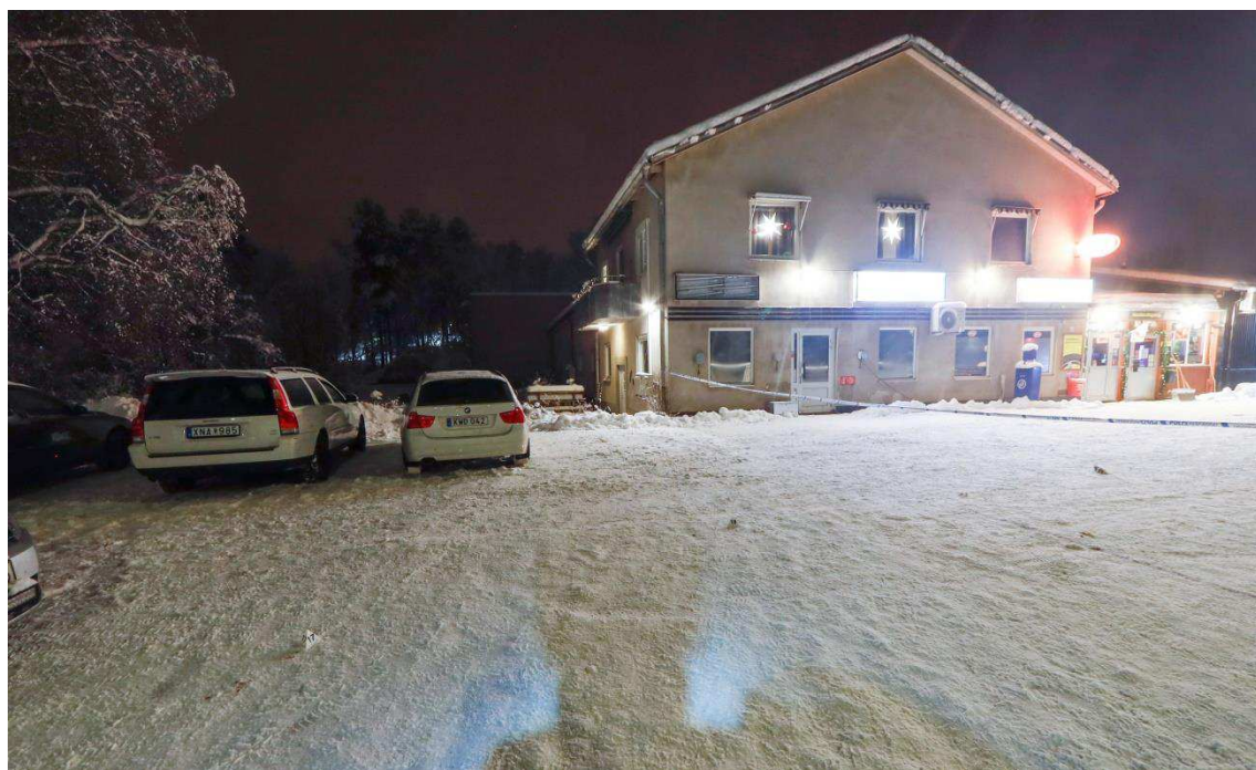
Figur 5. Visar parkeringsytan vid Centralgatan 42.
