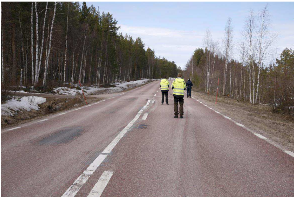
Figur 5. (Bild 6717) Samma vägsträcka, där avtagsvägen syns till vänster och vardera ojämnheten i norrgående körbana har markerats av var och en av personerna.
