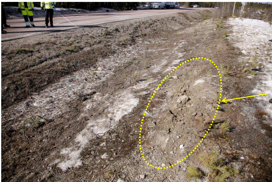
Figur 25. (Bild 6703) I området av ca 106-108 meter norr om nollpunkten, på vallen ovan diket, ses ett område med markpåverkan och uppstickande stenar. (Inringat område). Avståndet till snökanten ovan diket har här mätts till ca 8,6 m från asfaltkanten.
