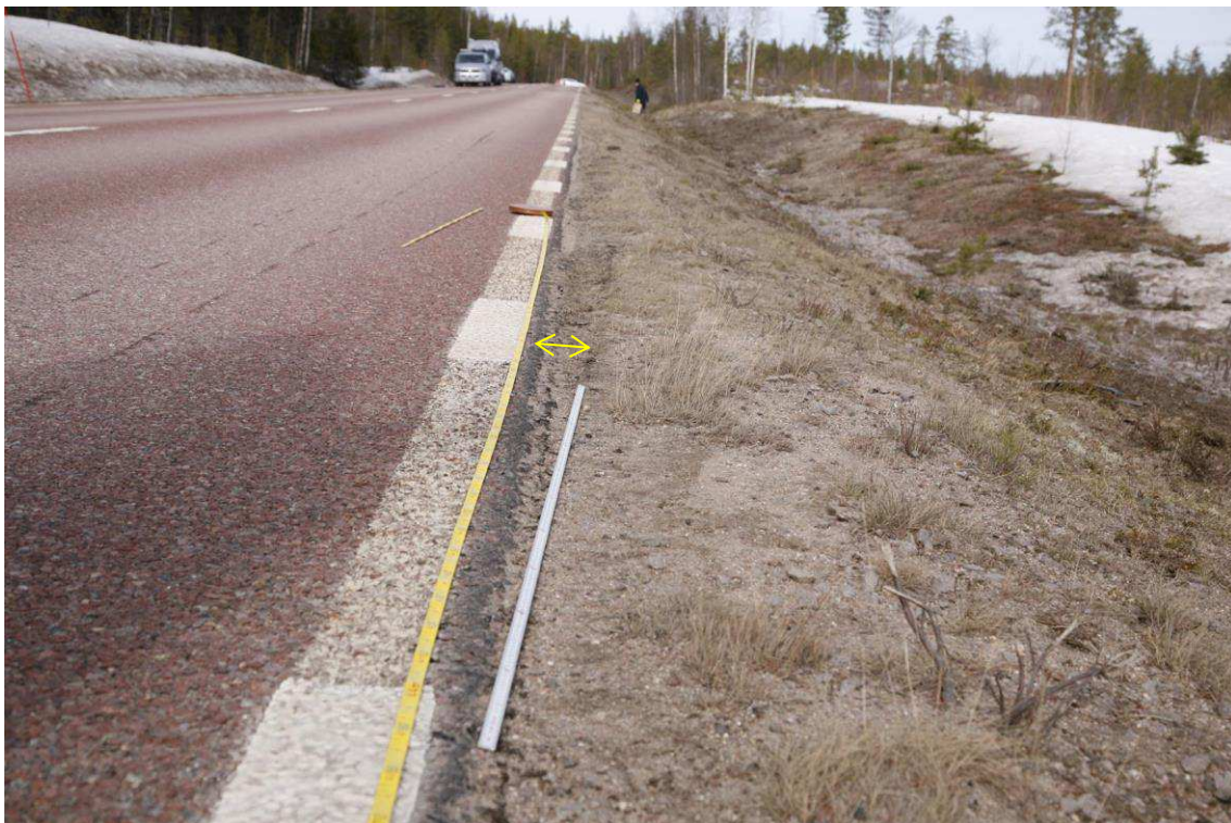
Figur 16. (Bild 6579) Ca 43,9 meter norr om nollpunkten. Här finns däckavtryck där det bedöms, att även det högra av andra axelns vänstra hjulpar går utanför asfaltkanten. Den vita tumstocken följer däckspårets riktning och dubbelpilen visar bredden på spåret från det vänstra hjulparet utanför asfaltkanten.
