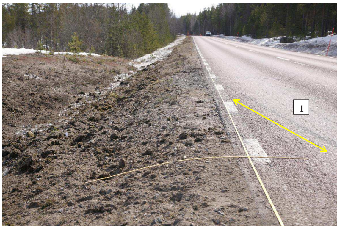
Figur 234. (Bild 6628) Vy söderut vid ca 90 meter norr om nollpunkten. Avståndet mellan asfaltkanten och tumstockens högra kant är ca 2,42 m. Söder om den punkten ses en fåra av kontaktsår, som bedöms vara avsatt från någon del av bussen under dess rörelse framåt. Början på det långa, svarta strecket ses från asfaltkanten vid dubbelpilen (nr 1).
