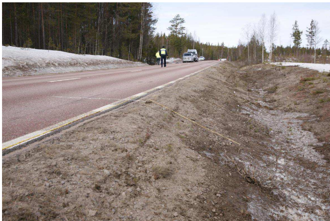
Figur 19. (Bild 6591) Samma avstånd som på föregående bild, (ca 60 m), från nollpunkten, men sett från en vinkel längre ner i vägrenen.
