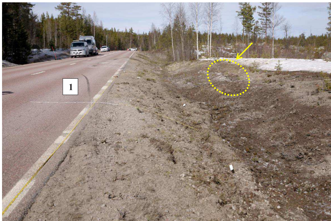
Figur 23. (Bild 6626) Vid ca 89 meter ses början på ett ca 13,6 m långt, svart streck i norrgående körbana. (Nr 1 på bilden). Inom det inringade området på vallen ovan diket, ses ett område med markpåverkan och uppstickande stenar, (se figur 25, 26).
