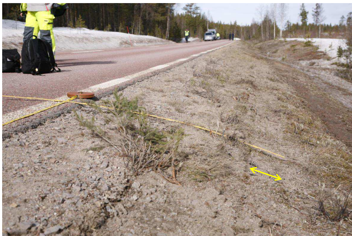
Figur 14. Bild 6561. Samma avstånd som på föregående bild, (ca 30 m), men sett från en vinkel längre ner i vägrenen. Dubbelpilen visar bredden på det tydliga däckavtrycket.
