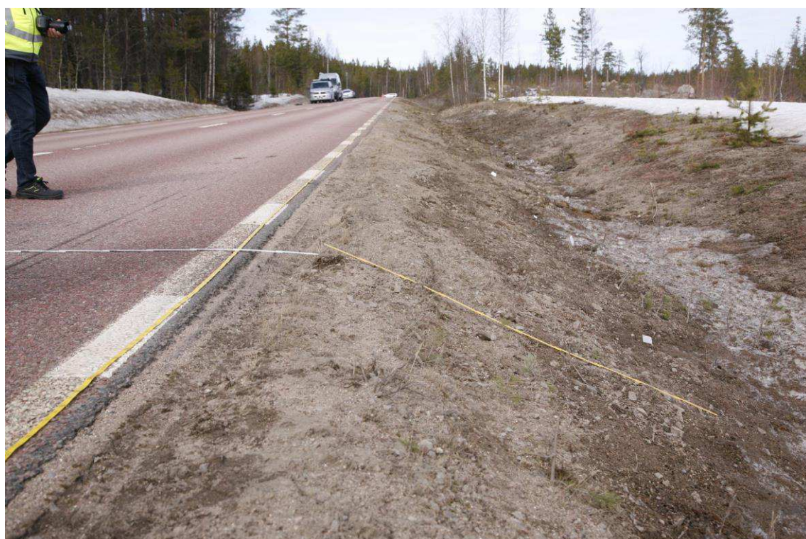
Figur 18. (Bild 6596) Ca 60 meter norr om nollpunkten. Avståndet mellan asfaltkanten och tumstockens högra kant där däckavtryckets högerkant iaktogs, mättes till ca 2,33 m. Här börjar också diket att få en brantare lutning.
