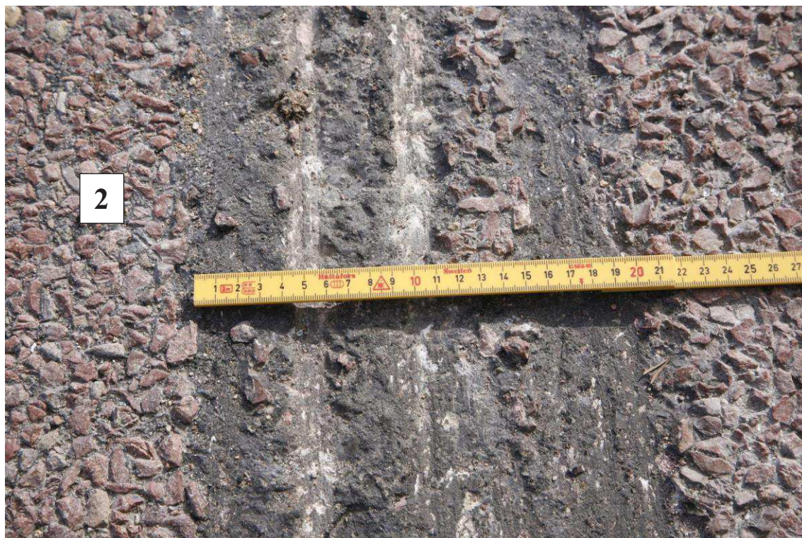
Figur 29. (Bild 6649) Närbild på det första, kortare rivspår (nr 2) från föregående bilder. Bredden mättes till ca 20 cm, med skåror vid ca 5 och 10,5 cm.
