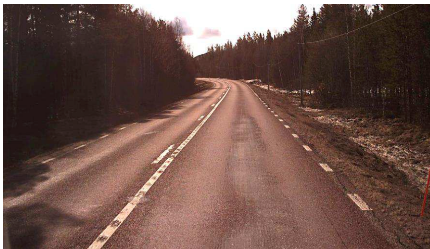
Figur 20: Planskrapat mellan hjulspåren sektion S 11 545 m
