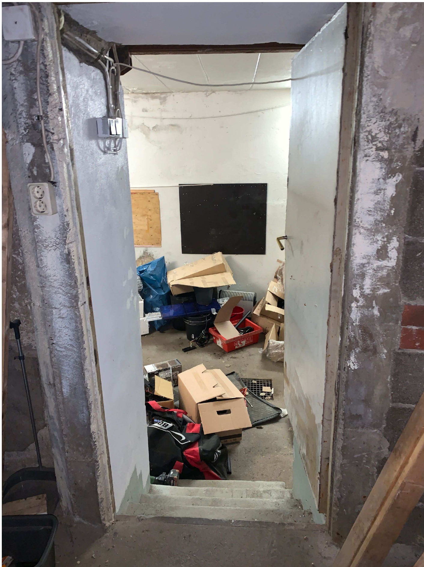
4. Dörren in till förrådet har blivit uppbruten av polis och har ej varit öppen för dem som hyrt förrådet.
