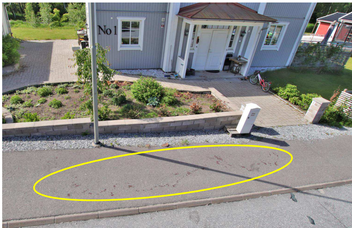
Figur 35. Området utanför Hålldammsvägen 1. Delar av droppserien på trottoaren inringad.
