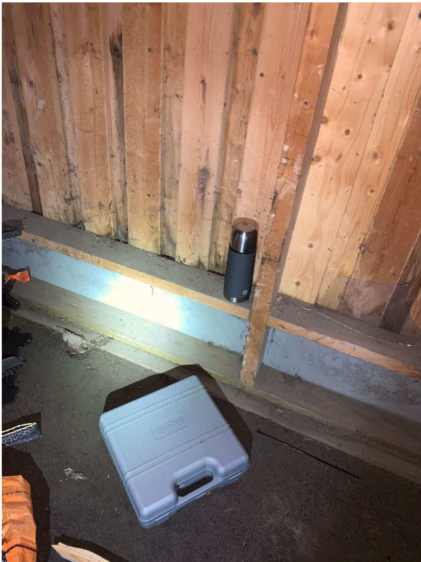
5. Första okulärbesiktning. (Beslag BG113231-1)
