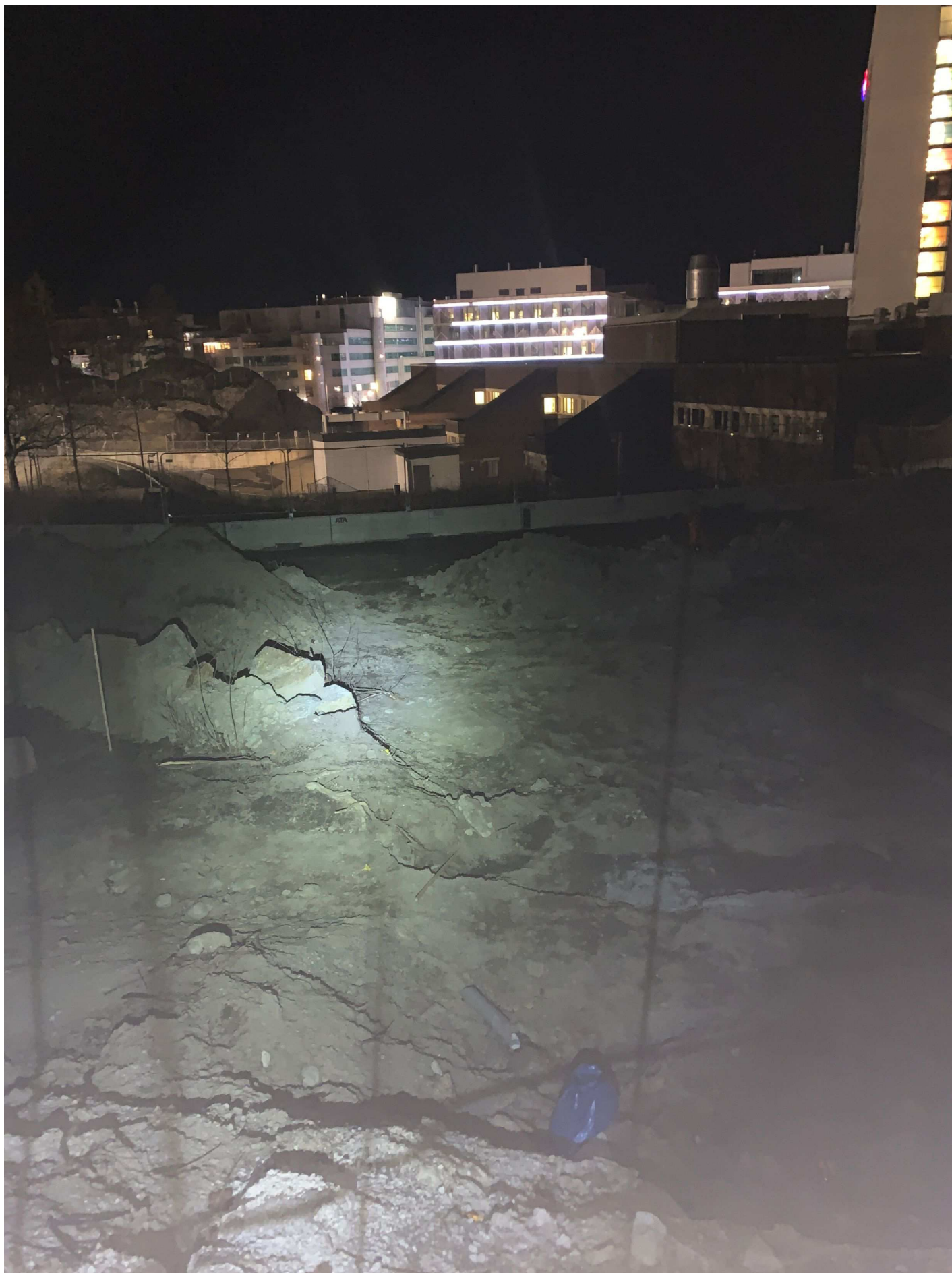
3. Bild tagen från stängslet som Berkay hoppade över ned mot Gula gången och arbetsplatsen.
