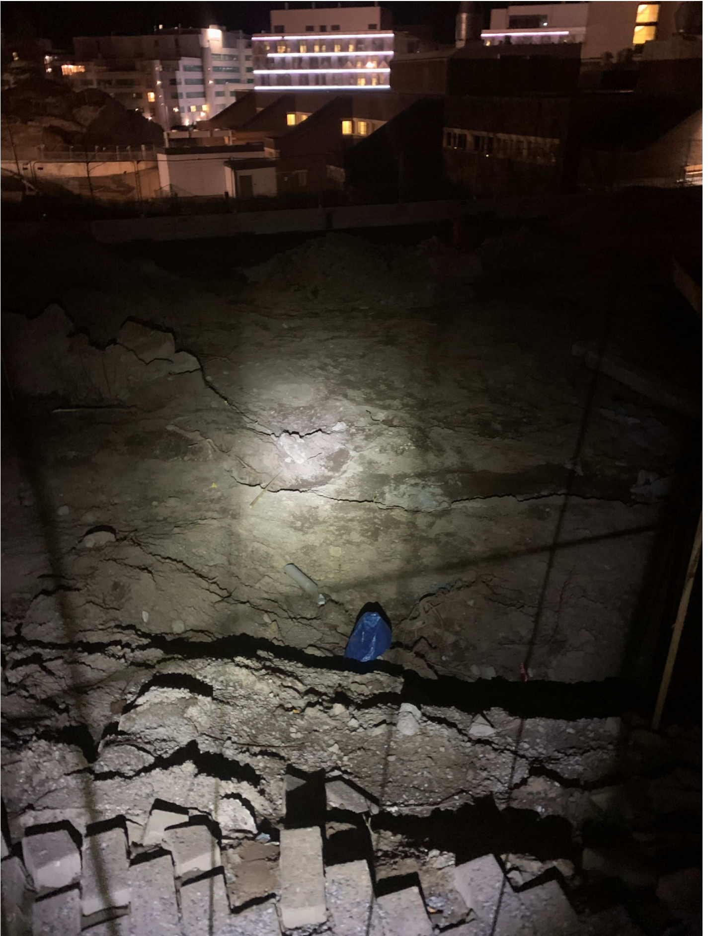
2. Bild tagen från stängslet som Berkay hoppade över ned mot Gula gången och arbetsplatsen.
