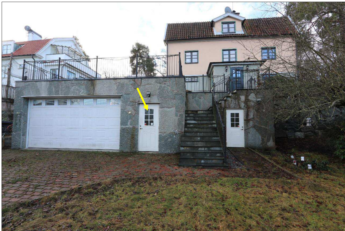
Figur 1. Huset sett från Lillsjönäsvägen. Pilen markerar ingången garaget.
