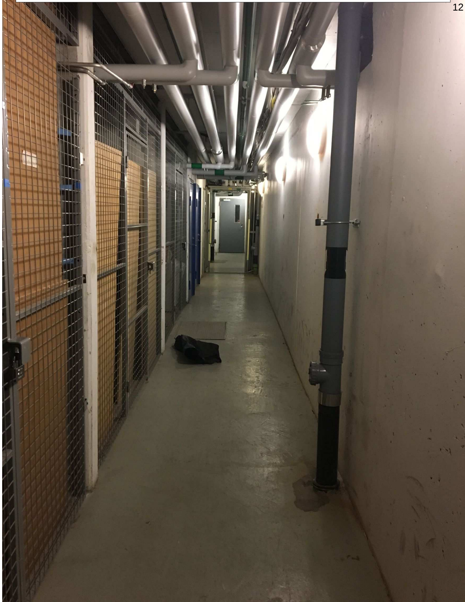
Översiktsbild på källargången. Väska som syns låg från början nere i golvluckan som även syns på bilden.
