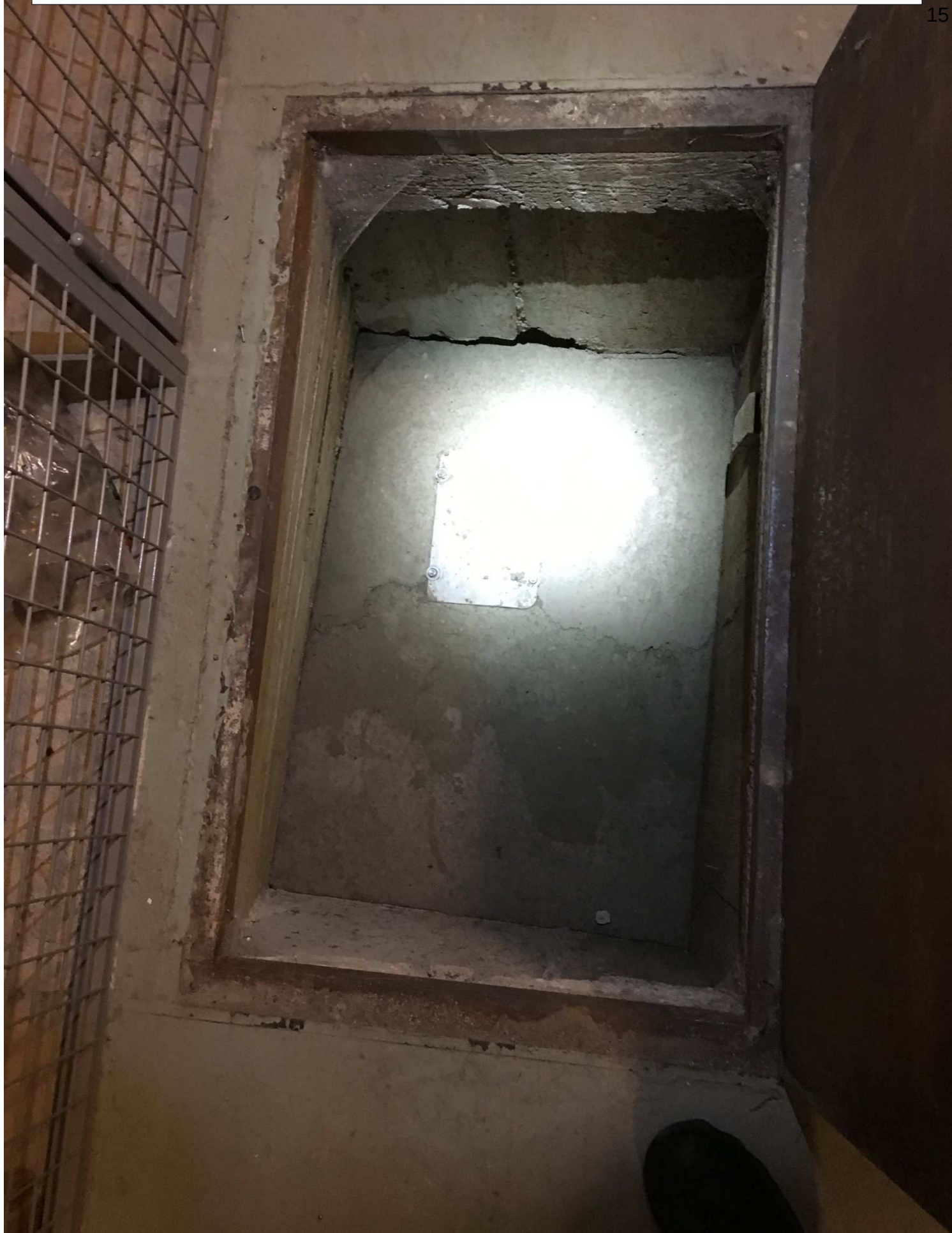
Golvlucka utanför förråd nr 1082,
