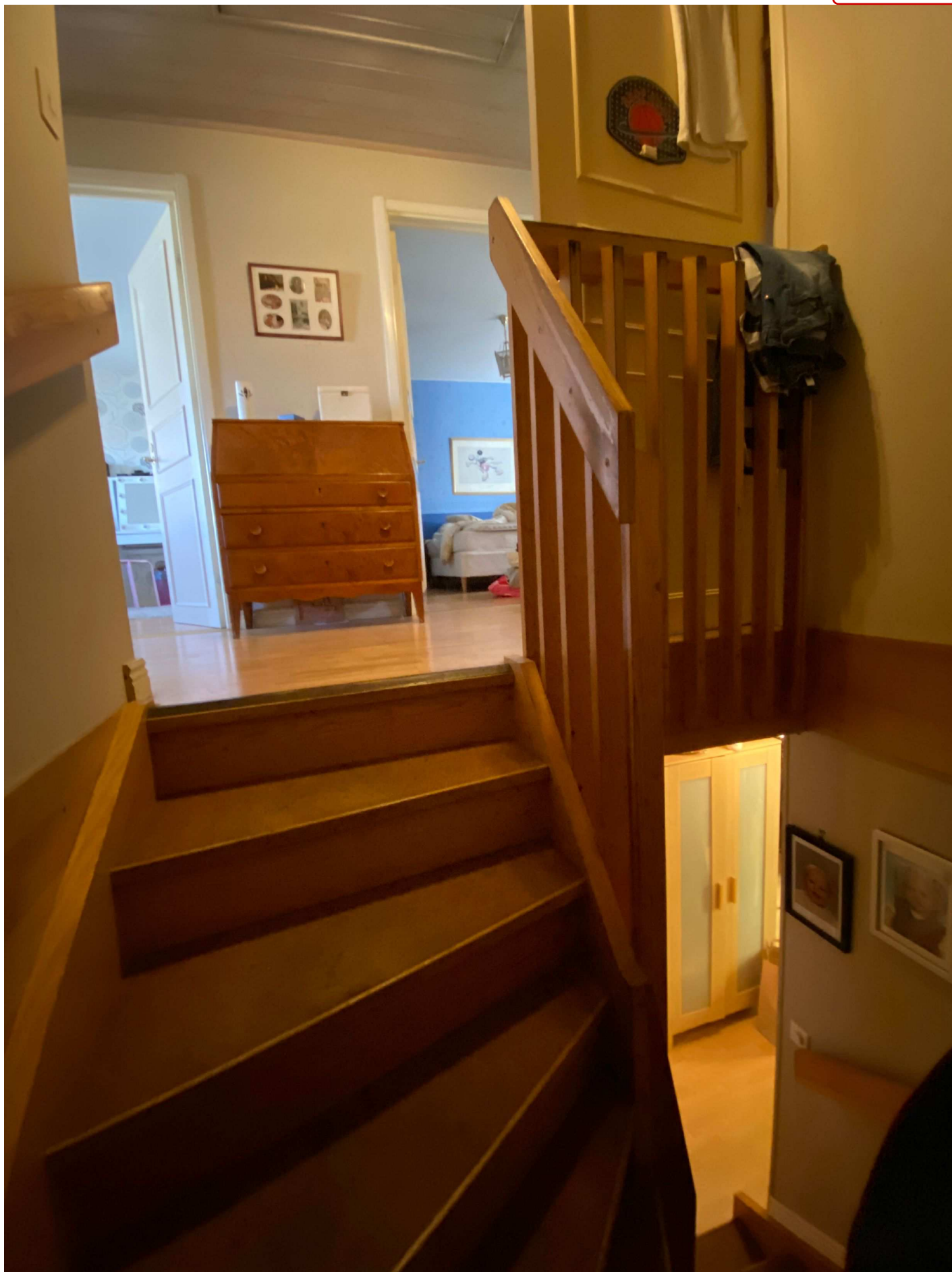
1. Foto på trappa taget i hörnan (under värmeflärten)
