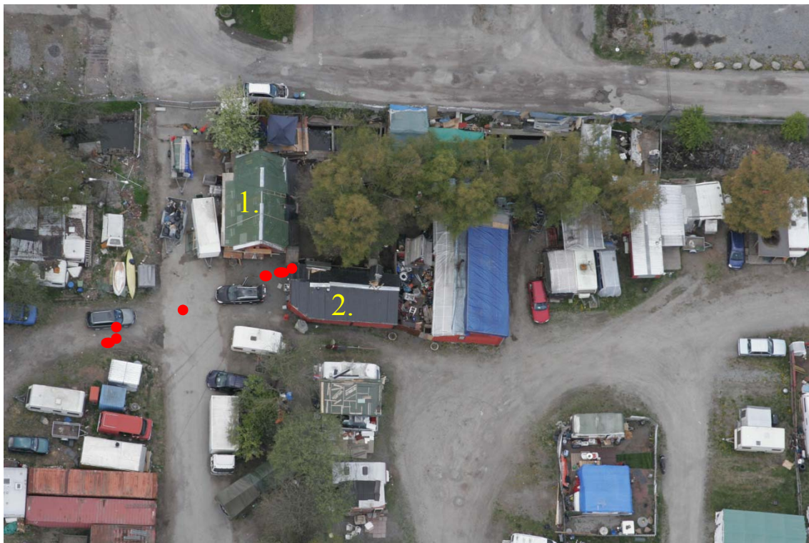
Foto 6. Aktuellt område av campingen sedd från öster. 1. = Skjul till vänster innanför gårdsport. 2. = Skjul utefter innergårdens högra sida. Röda prickar markerar platser där blod iakttagits på marken. (Fotograferat 2014-05-05)
