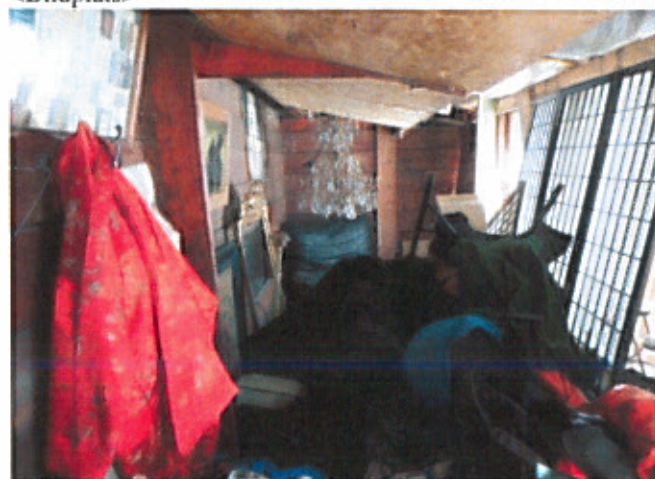
Utrymme mellan husvagn och yttervägg.
