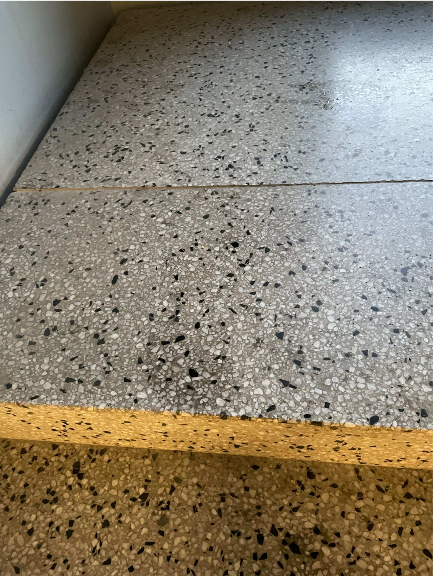
5. Plåtå mellan våning 2 och 3.
