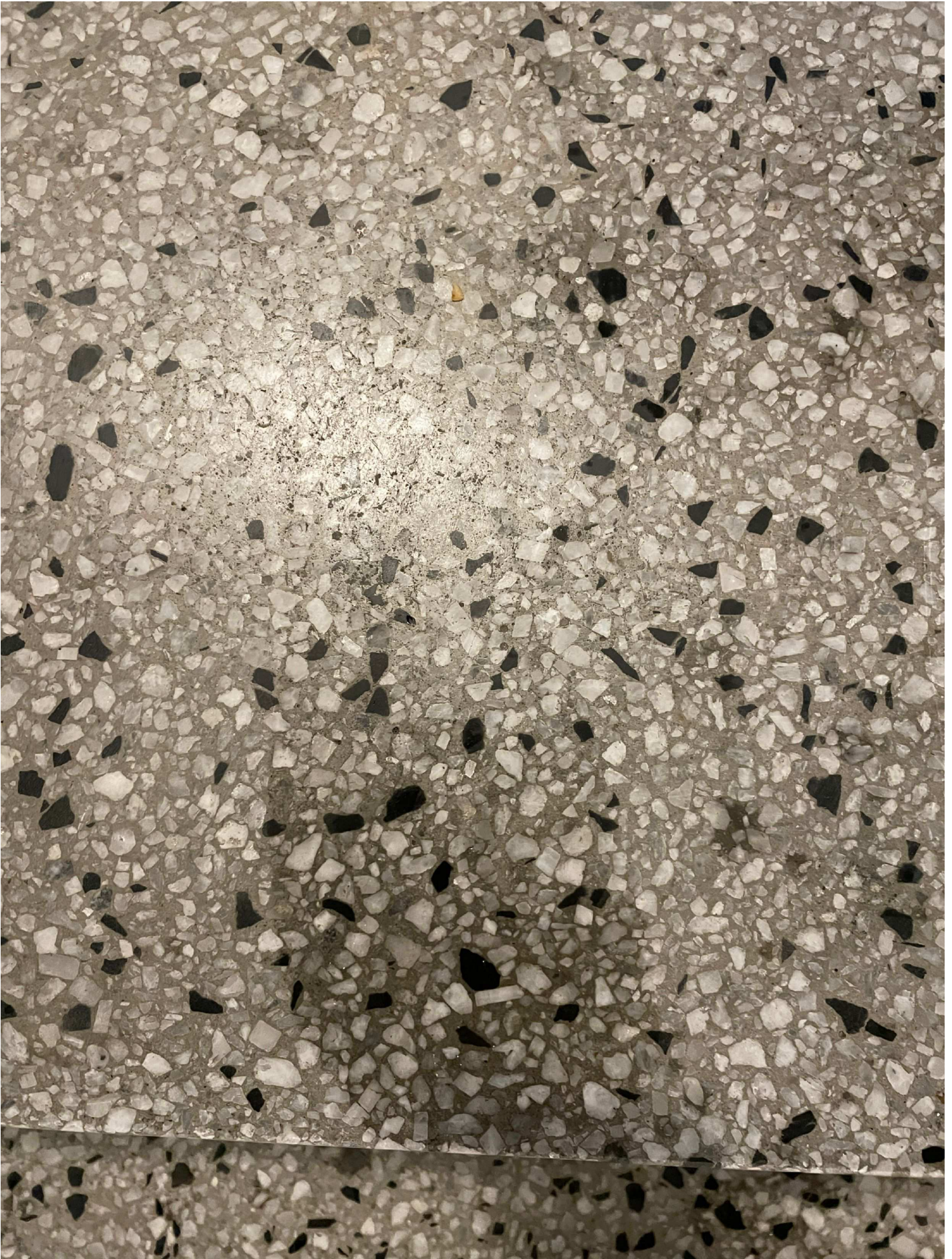
2. Plåtå mellan våning 2 och 3.
