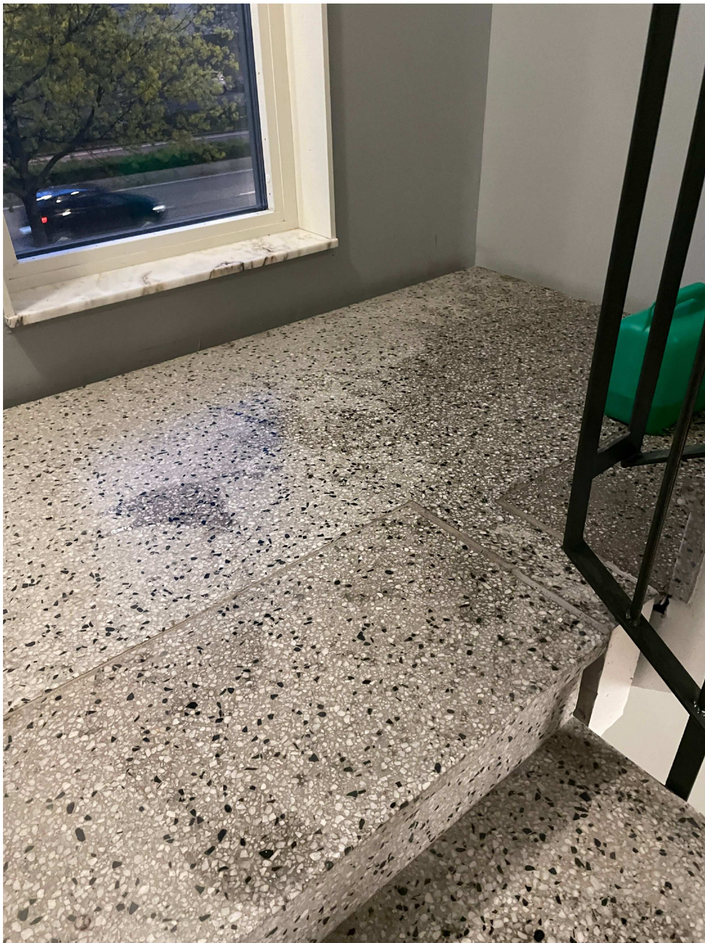
4. Plåtå mellan våning 2 och 3.
