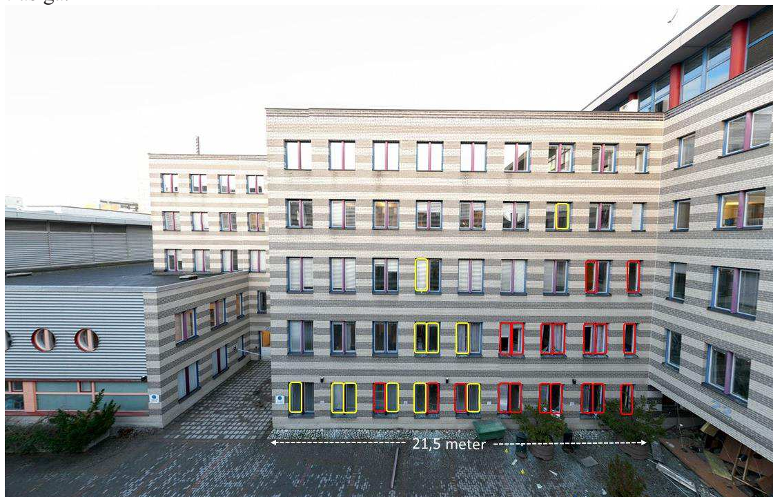
Figur 8. Röda rektanglar markerar fönster där både ytter- och innerfönster var trasiga. Gula rektanglar visar där ytterrutorna var trasiga.
