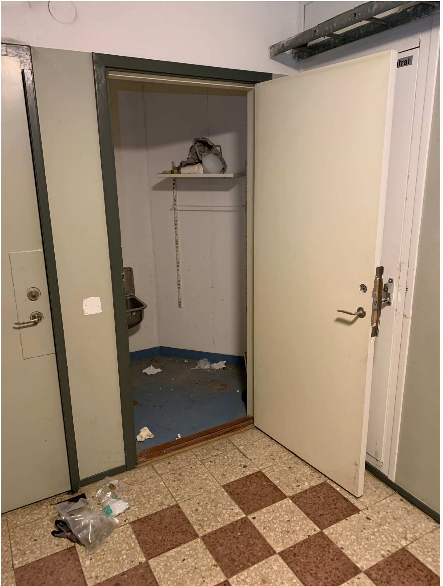
2. Utrymmet där vapnet och narkotikan påträffades.
