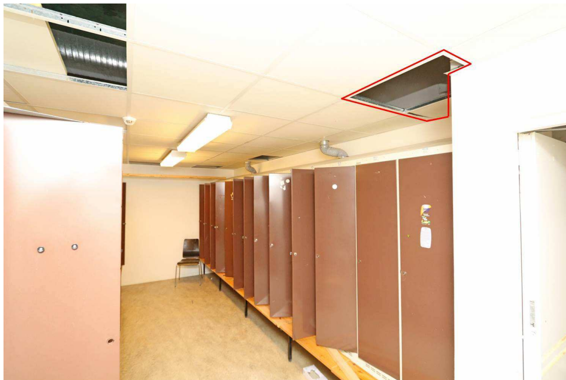
Bild 15: Platsen i omklädningsrummet direkt till höger ovanför trappan. Undersökt plats är markerad i bilden.
