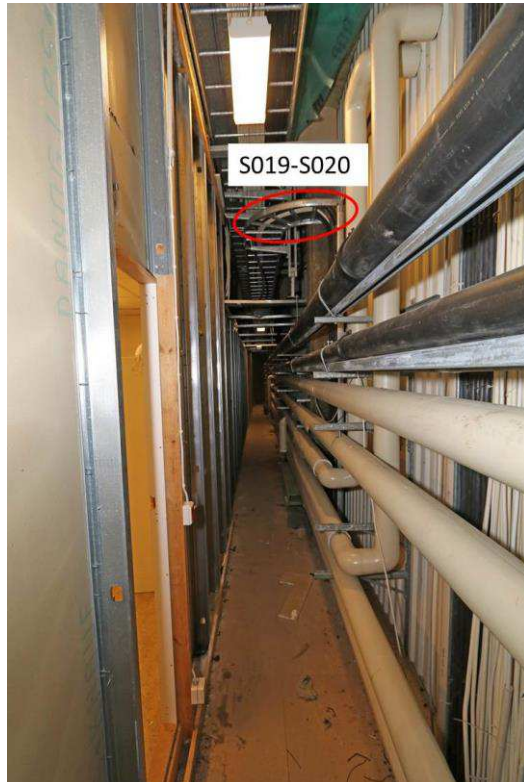
Bild 38: Gångens yttre del. Platsen där spår säkrades är markerat i bilden.
