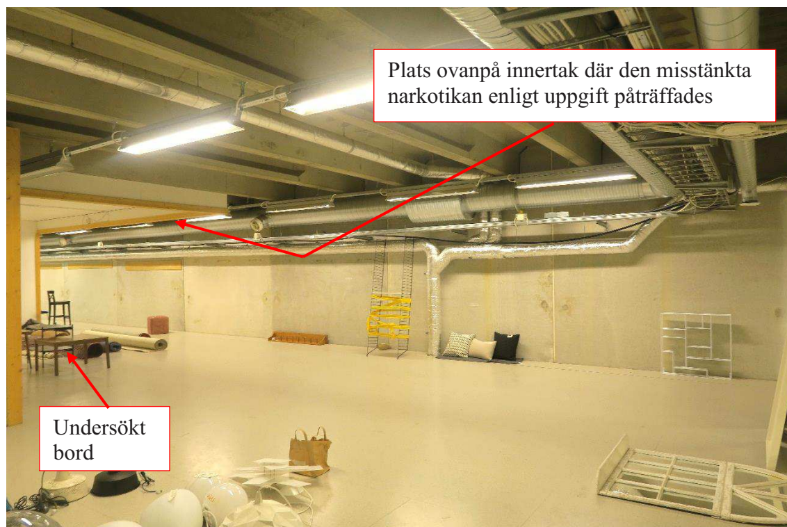
Figur 5. Övervåningen fotograferad från entrén från trappan.
