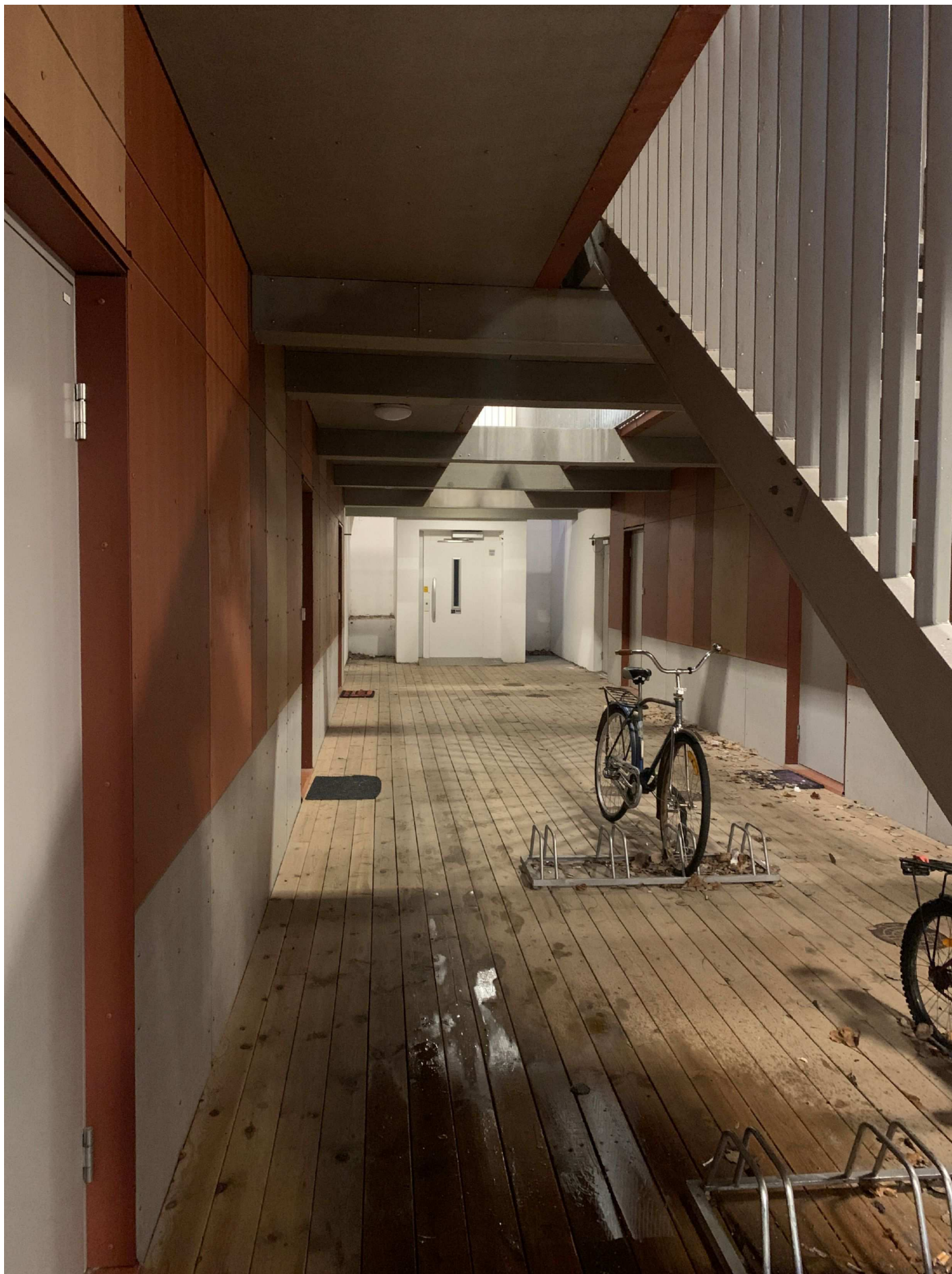
2. Kvarnbergsvägen 31A 141 45 Huddinge. Hissdörr vid bottenvåning
