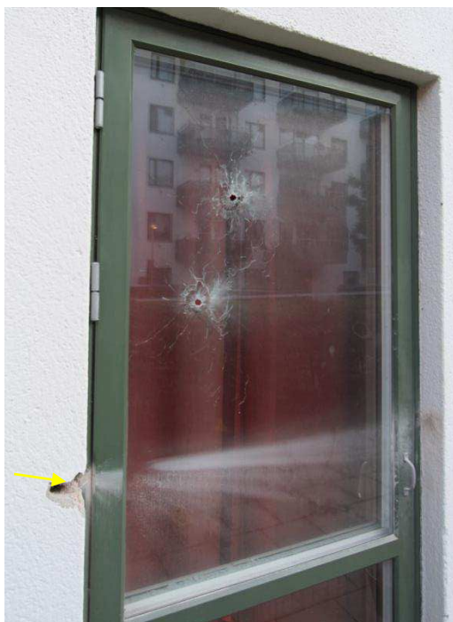
Figur 16: Altandörren. Pilen markerar kulans riktning.
