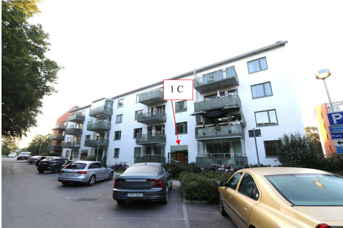
Figur 4: Råckstavägen 1 C, huvudentrén. Framsidan av fastigheten.
