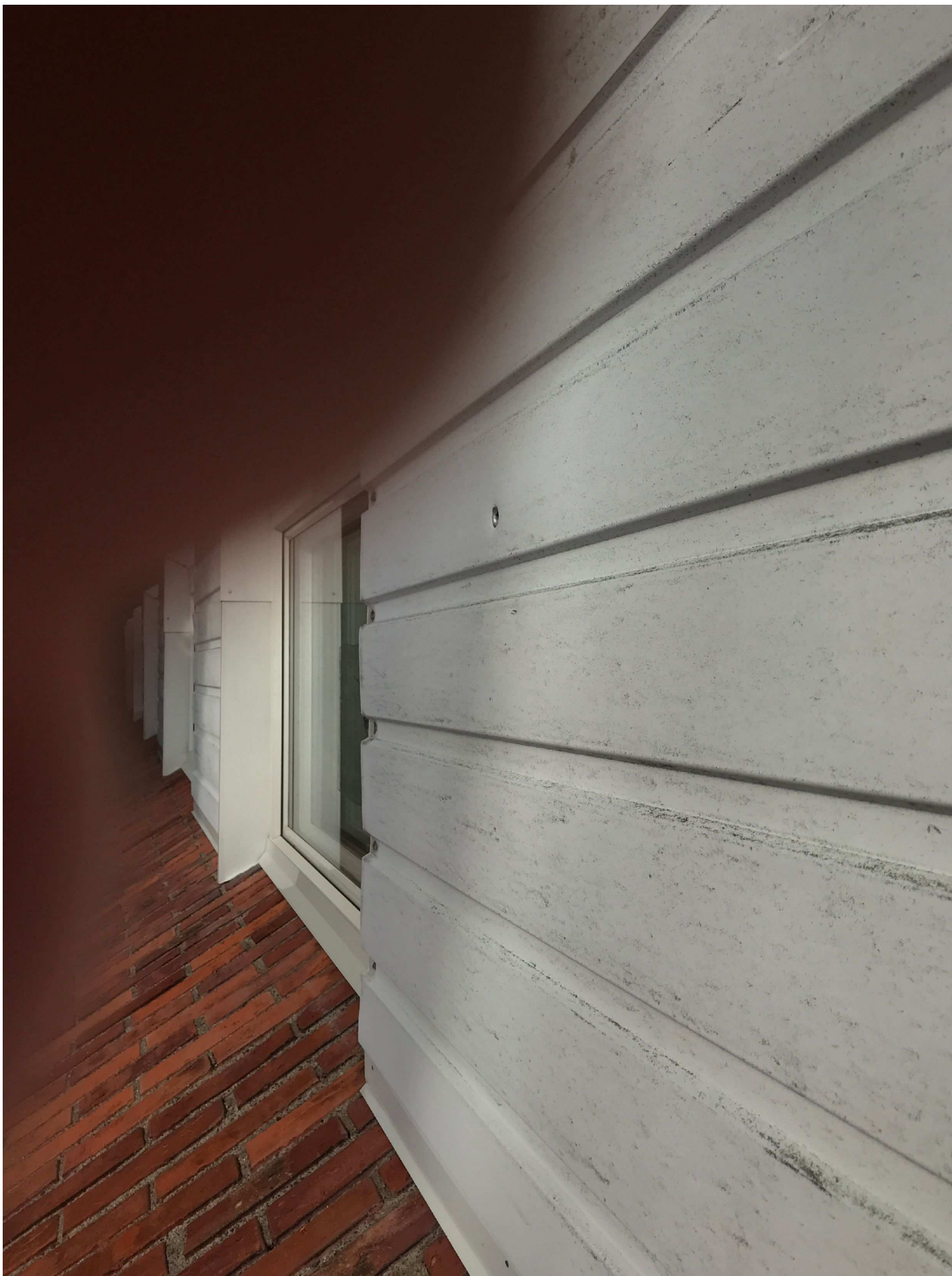
9. Ingångshål i fasaden
