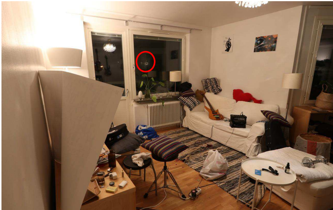
3. Översiktsbild över vardagsrummet. Skottskada i fönstret intill balkongdörren markerat med en röd cirkel.
