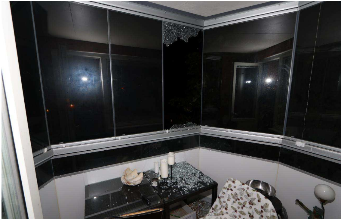
2. Balkongen på våning tre med krossad ruta i inglasningen. Bilden tagen ut från balkongdörren i vardagsrummet.
