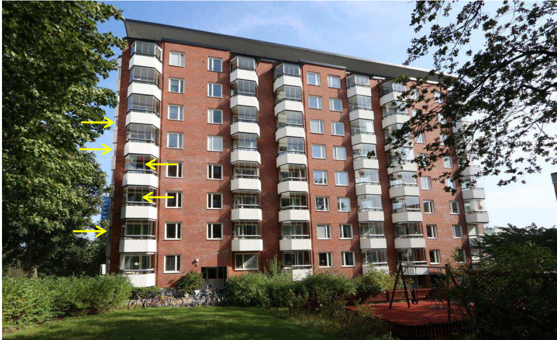
10. Alphyddevägen 23, den sida som vetter i riktning mot vändplanen. Vänstra gaveln vetter ut mot vägen. Pilarna visar i vilka balkonginglasningar och burspråk kulor gått in. (Huset fotograferat i dagsljus den 10 september 2019).
