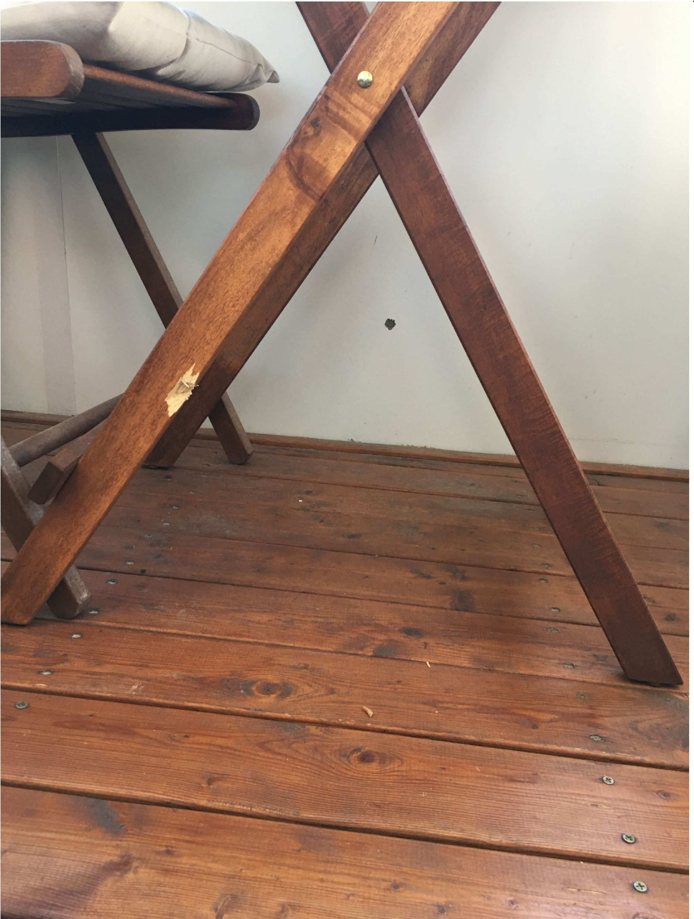
3. Närbild på kulhål på balkongens insida samt skada på bordsben. Skadornas placering på balkongen och bordsbenet är cirka 10-15 cm från balkonggolvet.
