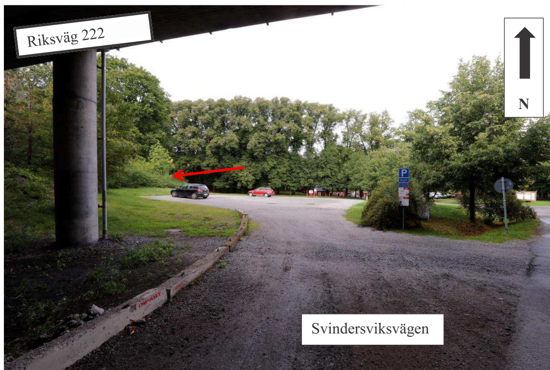
Figur 2. Fotograferat under riksväg 222 i nordlig riktning mot Svindersvik. Pil markerar aktuellt buskage. Bilden är tagen i dagsljus 2019-09-11.
